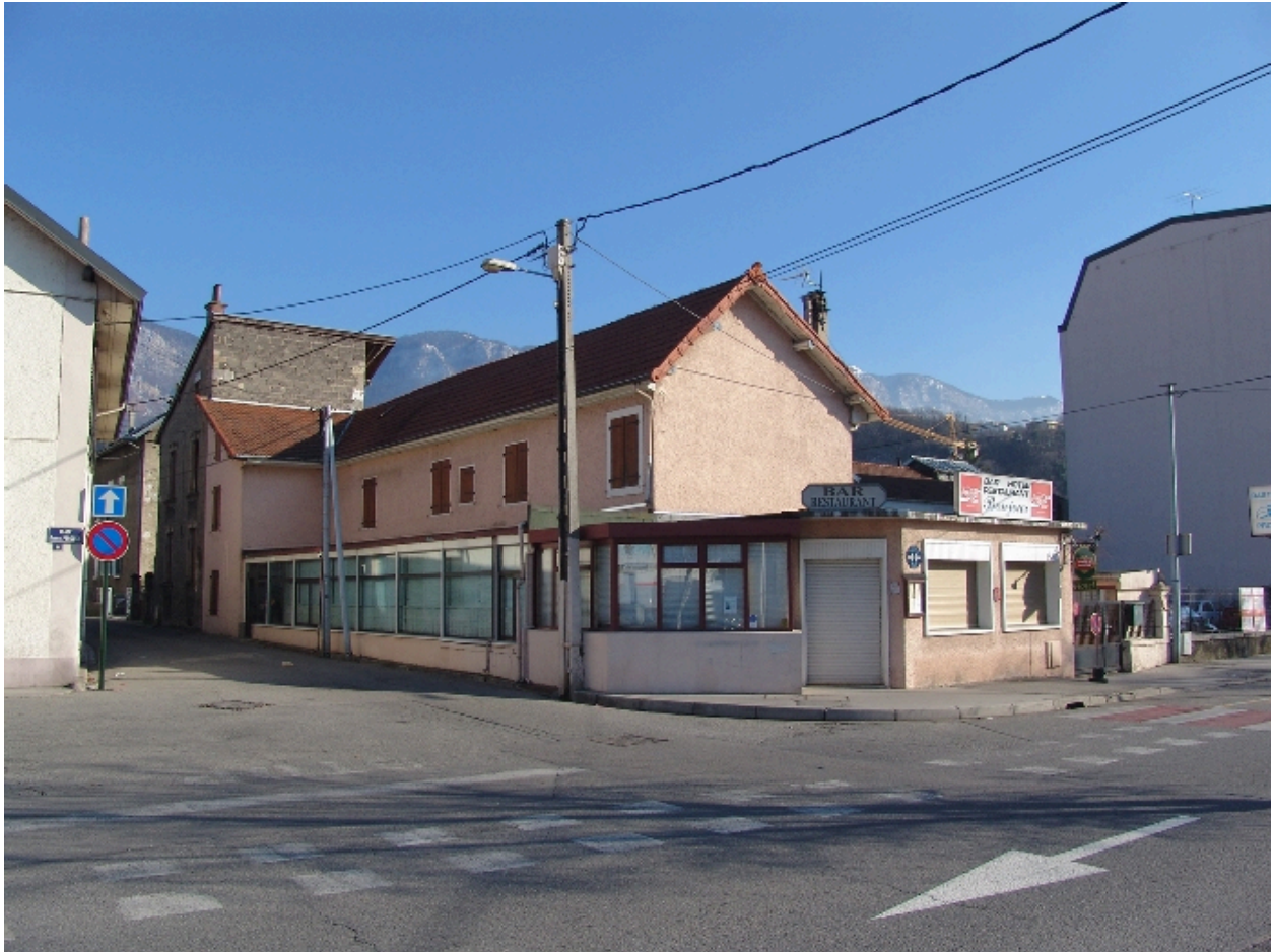
Façades sur rue
