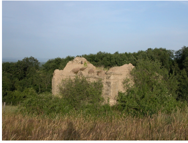
Vue générale. Phot. Thierry Monnet IVR82_20134200752NUCA
