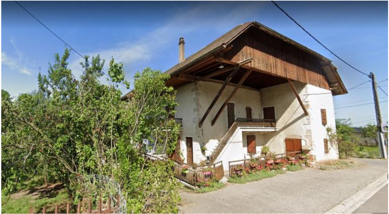
Vue d'ensemble du logis primitif à l'est de la ferme, avec poste à lait en saillie de la façade, de plain-pied.
