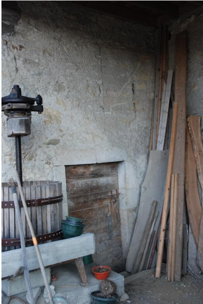
Vue partielle de l'intérieur de l'espace ouvert et couvert de la façade nord avec présence des jours de placard en haut à droite de la porte d'accès à la cave.
