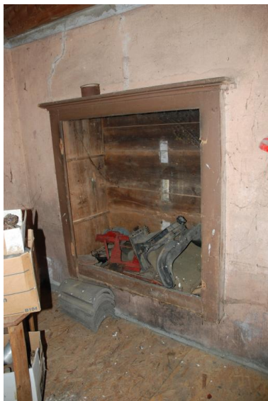
Vue d'ensemble du placard de la chambre du second logis avec ouvertures ouvrant sur l'extérieur, au nord. Phot. Thierry Monnet IVR84_20207401754NUCA
