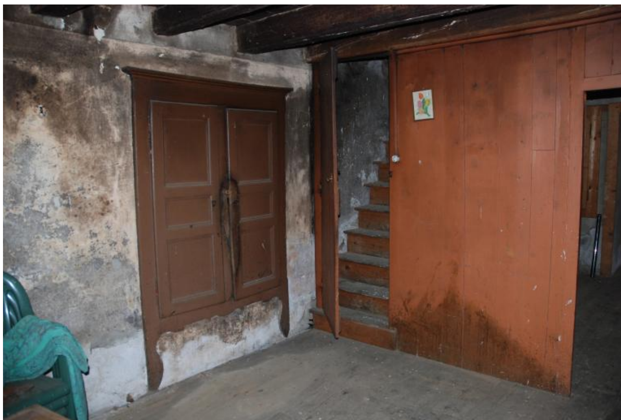
Intérieur de la cuisine du second logis. Présence d'un des quatre placards muraux et du départ de l'escalier en bois.
