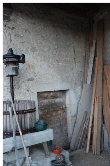
Vue partielle de l'intérieur de l'espace ouvert et couvert de la façade nord avec présence des jours de placard en haut à droite de la porte d'accès à la cave. Phot. Thierry Monnet IVR84_20207401752NUCA
