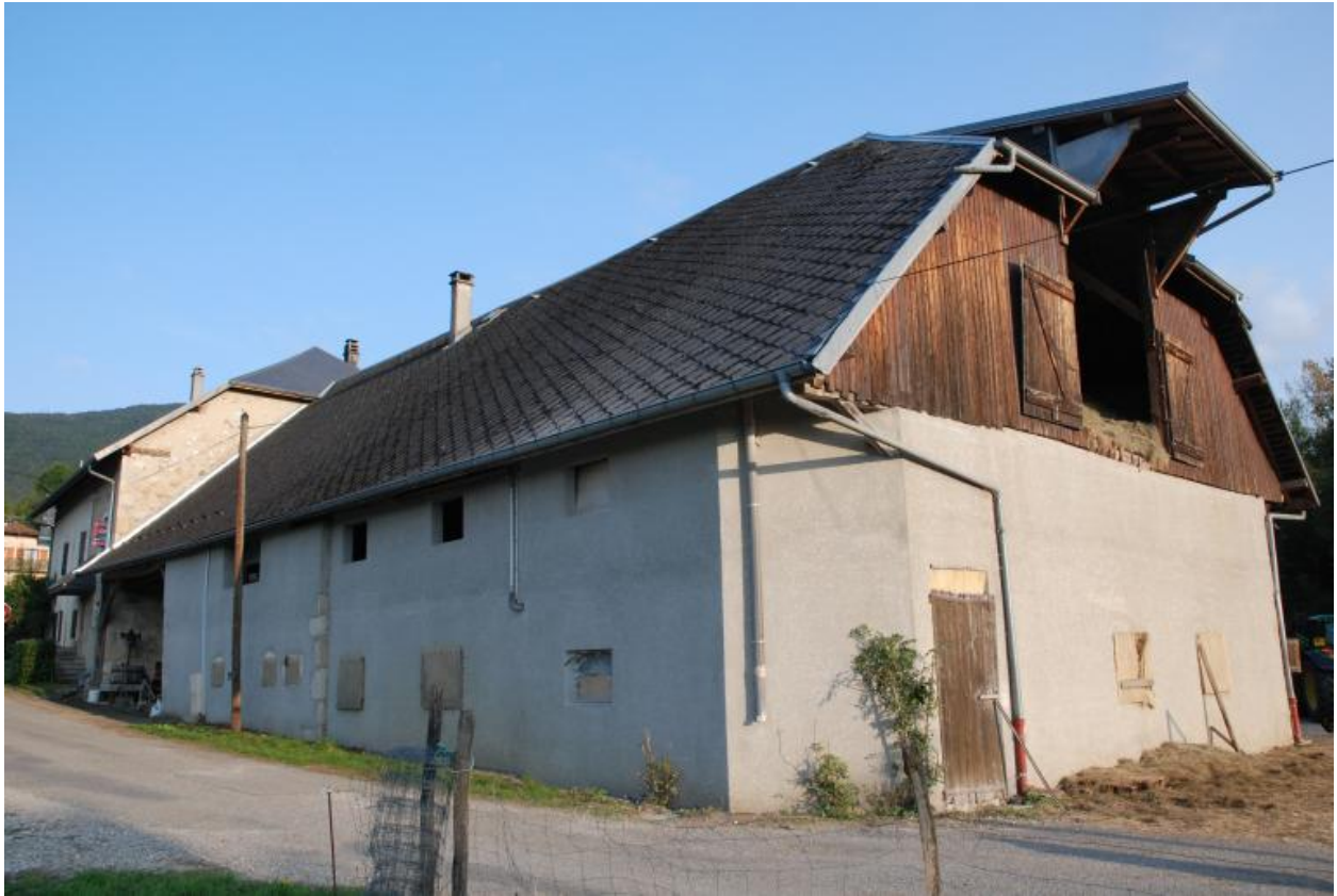
Vue générale de la façade arrière, avec trace des ouvertures de l'ancienne fruitière à droite de l'espace ouvert et couvert.
