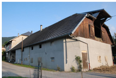
Vue générale de la façade arrière, avec trace des ouvertures de l'ancienne fruitière à droite de l'espace ouvert et couvert. Phot. Thierry Monnet IVR84_20207401753NUCA
