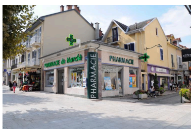
Vue d'ensemble Phot. Denys Harreau IVR82_20157300954NUCA
