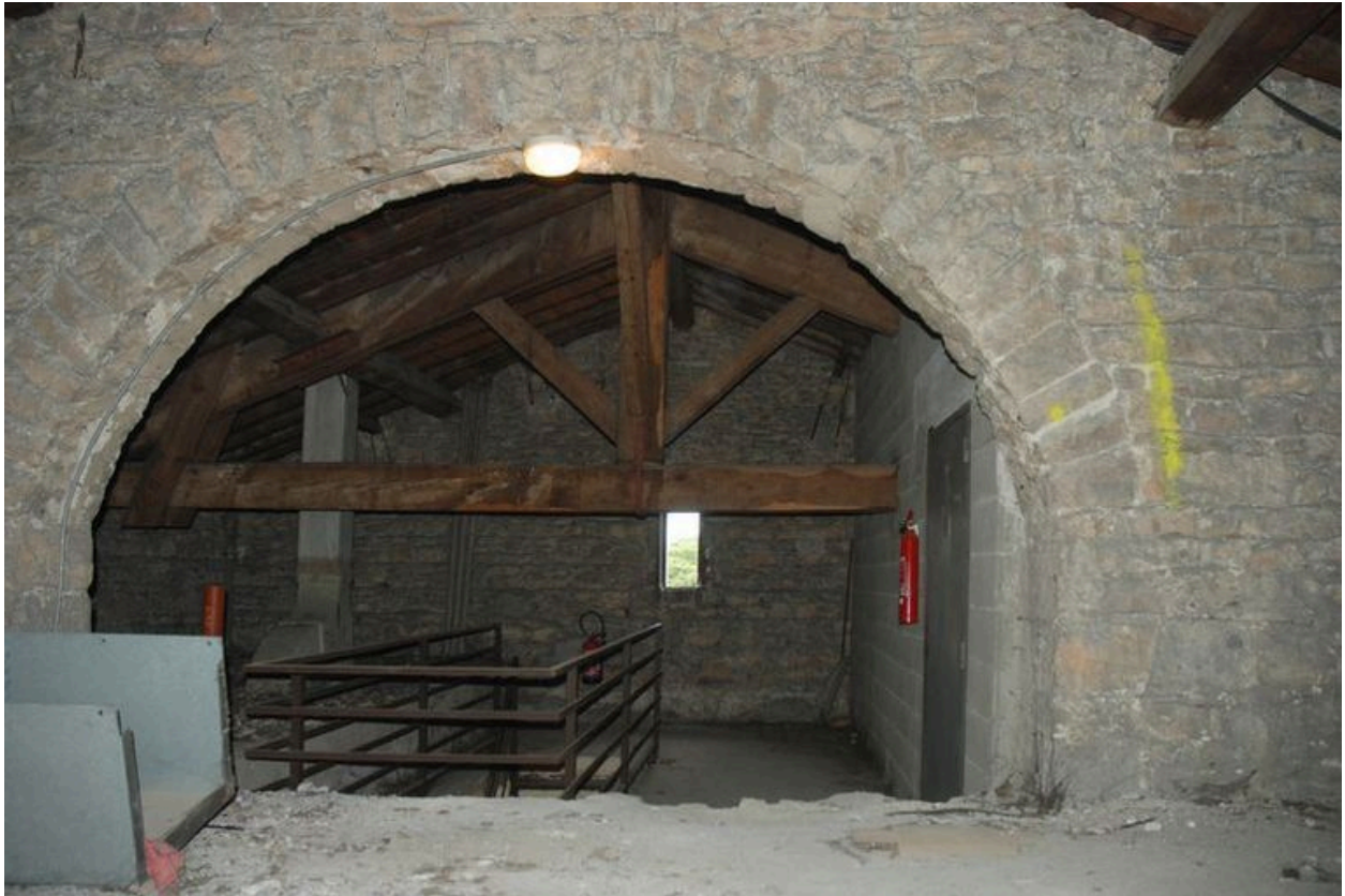
Combles : arc en moellons
