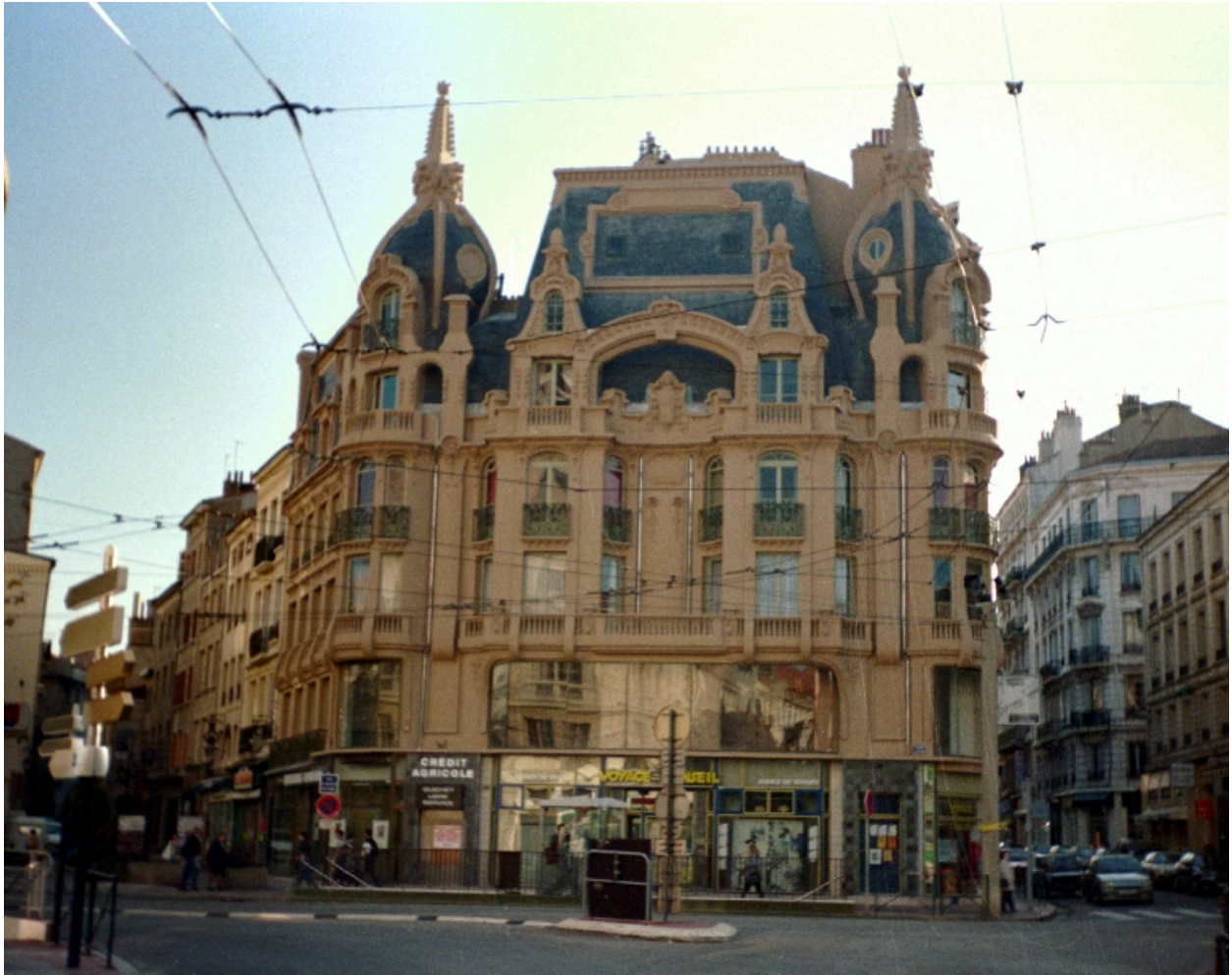
Façade principale, avenue de la Libération
