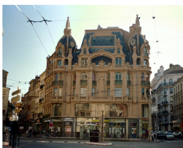
Façade principale, avenue de la Libération Phot. Cendrine Sanquer IVR82_19974201996ZE
