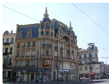
Vue d'ensemble Phot. Cendrine Sanquer IVR82_20084200514NUCA
