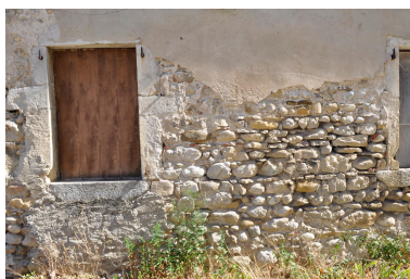
Détail de la maçonnerie en façade Phot. Magali Delavenne IVR84_20200101132NUCA
