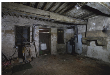
Maison du jardinier, vue intérieure Phot. Franck Trabouillet IVR84_20200100864NUCAQ
