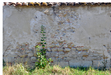
Mur de clôture à l'ouest de la maison du jardinier, maçonnerie de moellons, galets et tuiles Phot. Magali Delavenne IVR84_20200101018NUCA
