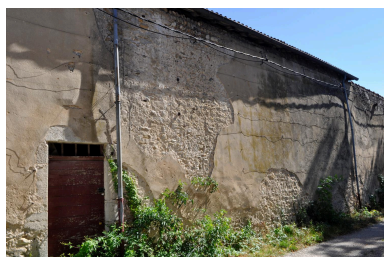
Portion de mur enclavée entre la maison du jardinier et l'orangerie, maçonnerie de galets Phot. Magali Delavenne IVR84_20200101135NUCA
