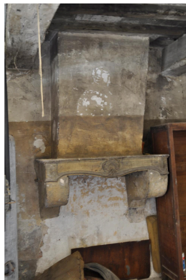
Cuisine, linteau de cheminée du 18e siècle, en remploi Phot. Magali Delavenne IVR84_20200101134NUCA
