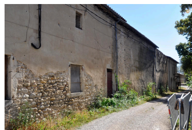
Ensemble du bâtiment dépendant de l'ancienne ferme du château, avec la maison du jardinier à gauche de l'image Phot. Magali Delavenne IVR84_20200101131NUCA
