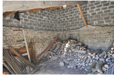
Bûcher, vue intérieure Phot. Magali Delavenne IVR84_20200101129NUCA
