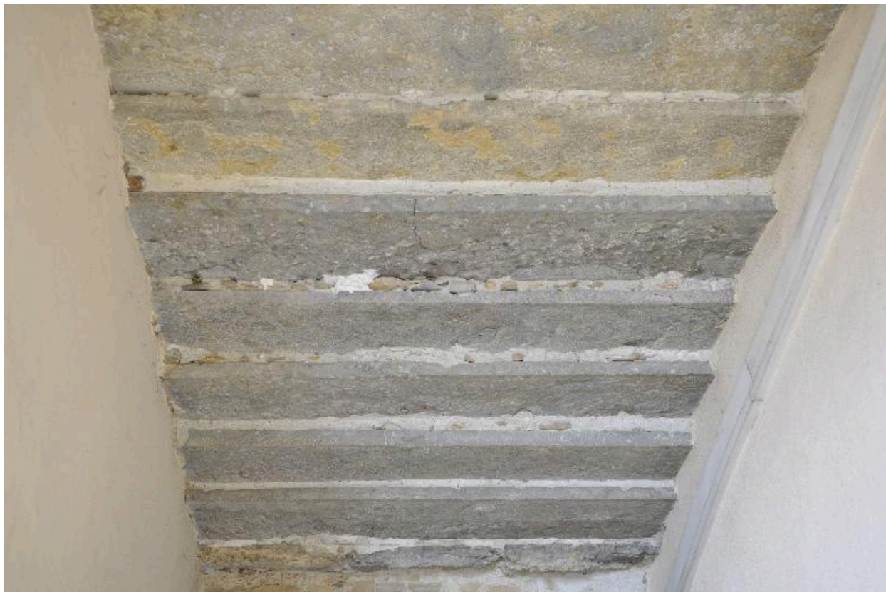
Détail d'une volée aux marches délardées de l'escalier du n°6 rue Dumenge
