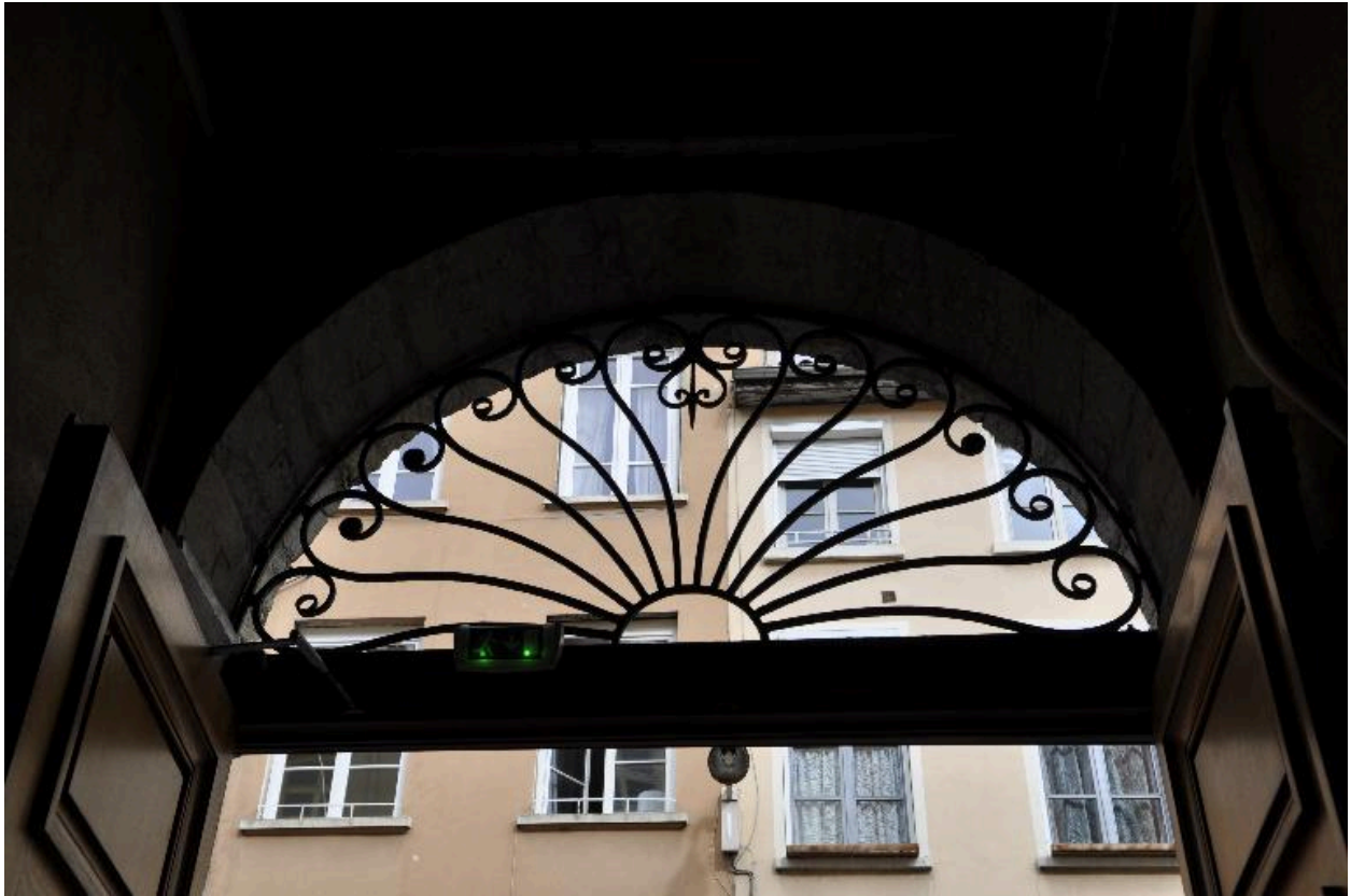
Imposte de la porte d'entrée de l'immeuble n°6 rue Dumenge et n°4 rue Dumenge
