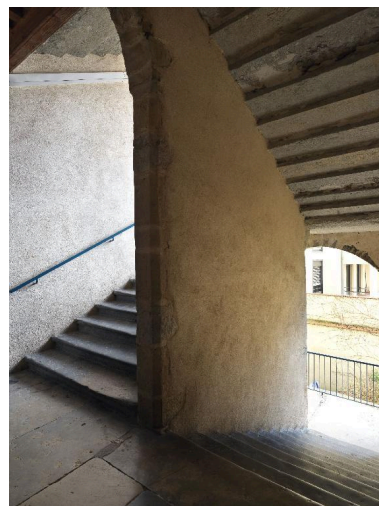
Vue des volées et du mur noyau depuis un palier de l'escalier du n°6 rue Dumenge Phot. Thierry_Leroy IVR82_20136901305NUCAQ
