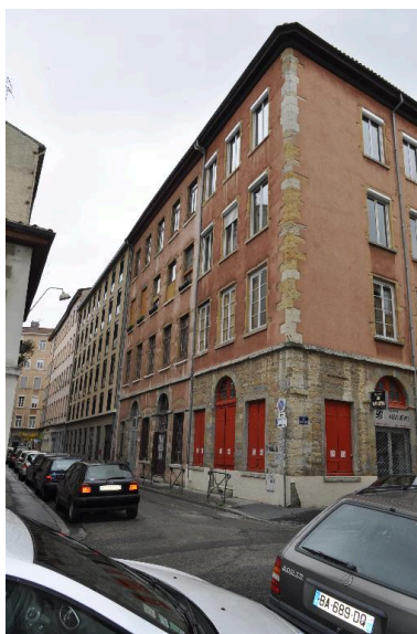
Façade latérale du n°6 rue Dumenge sur la rue du Pavillon Phot. Nadine Halitim-Dubois IVR82_20136900459NUCA
