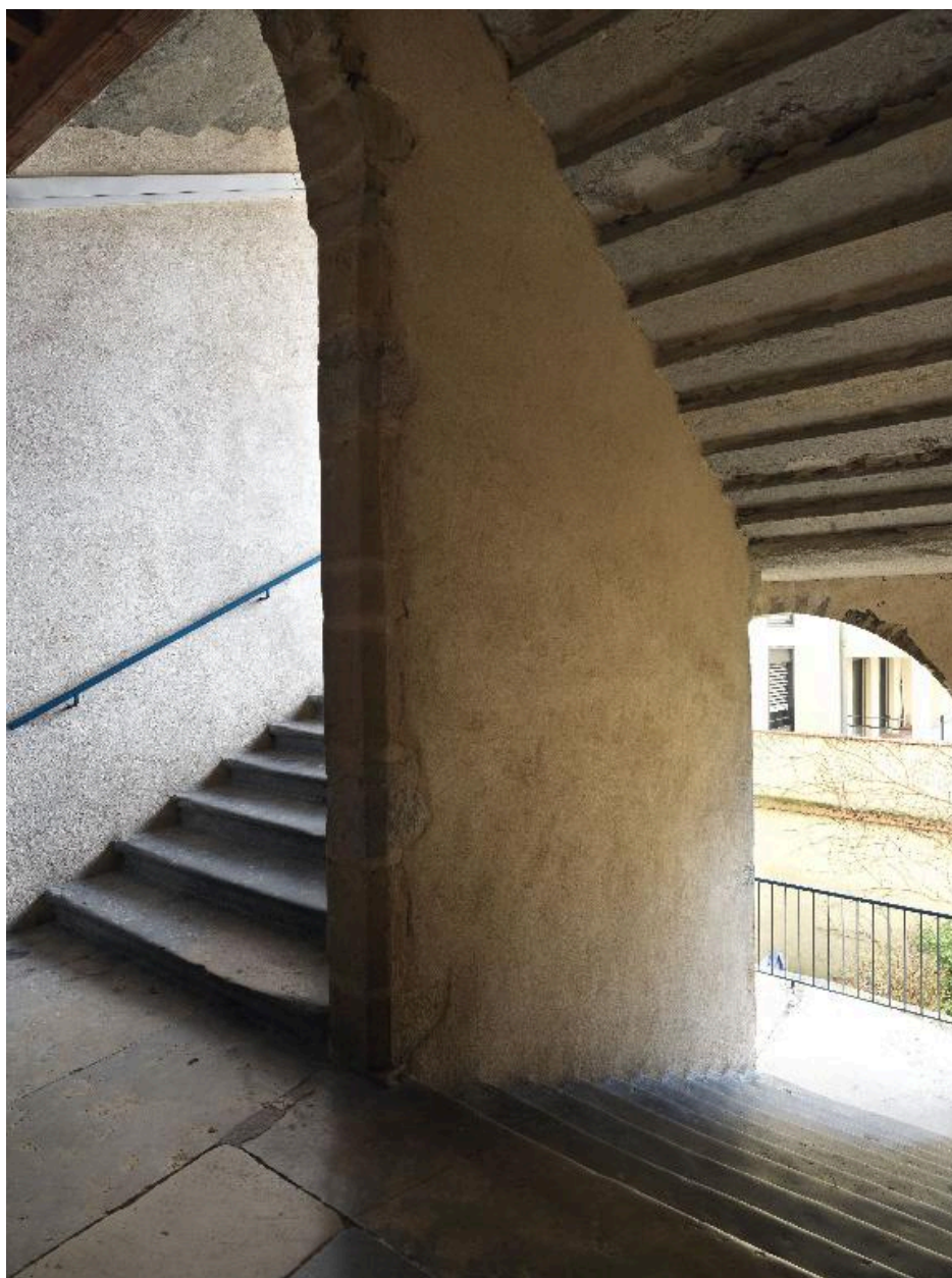
Vue des volées et du mur noyau depuis un palier de l'escalier du n°6 rue Dumenge
