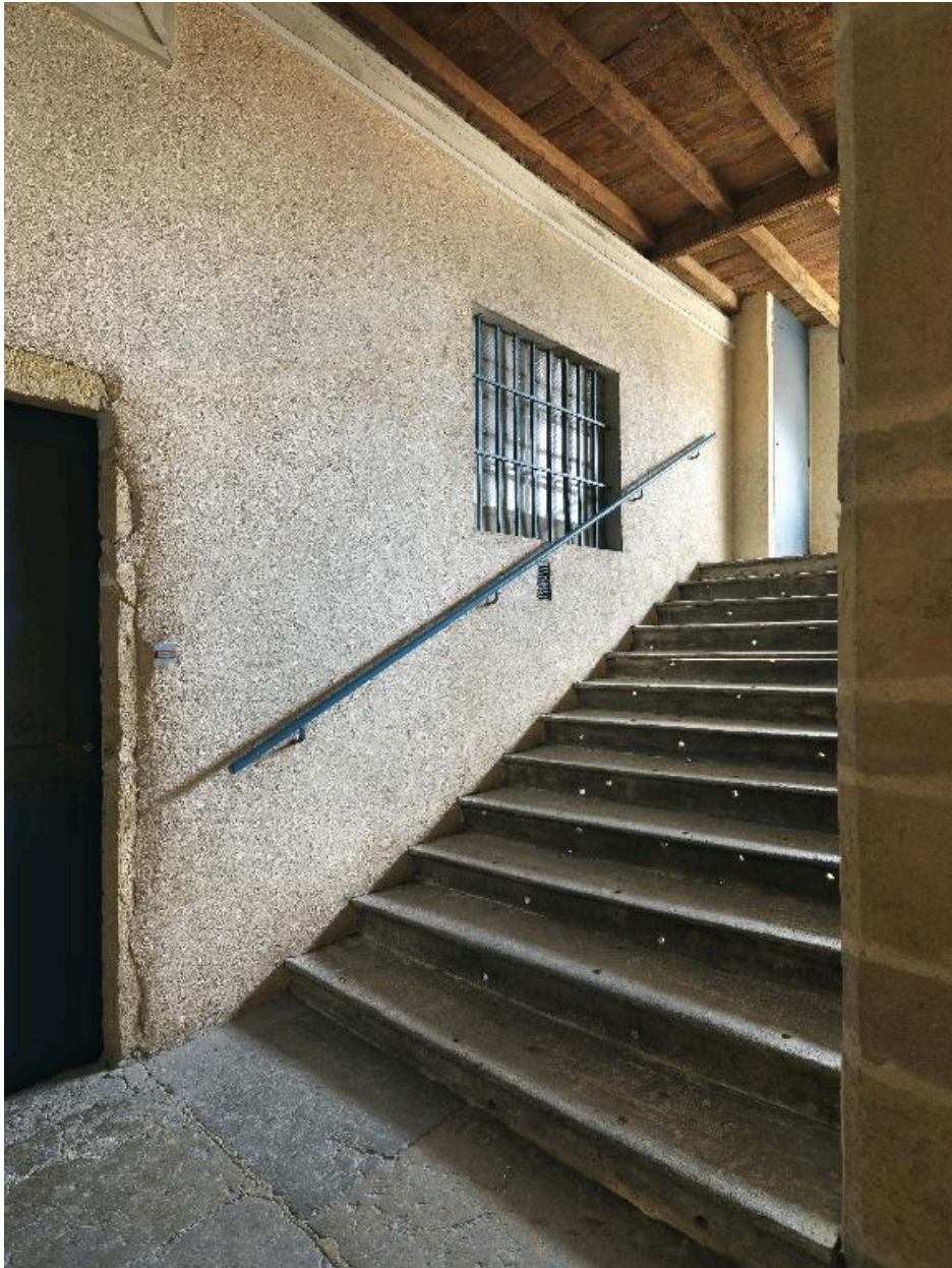
Première volée en bois permettant d'accéder au dernier niveau de l'escalier du n°6 rue Dumenge
