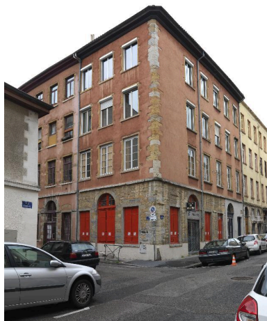
Vue d'ensemble du n°6 rue Dumenge depuis l'est Phot. Thierry_Leroy IVR82_20136901396NUCAQ
