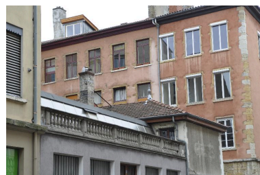
Deuxième et troisième étages du n°6 rue Dumenge sur la rue du Pavillon Phot. Nadine Halitim-Dubois IVR82_20136900469NUCA
