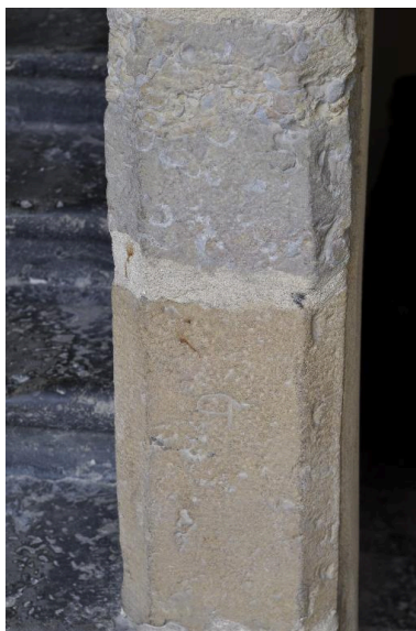
Marques lapidaires sur le mur noyau de l'escalier du n°6 rue Dumenge Phot. Nadine Halitim-Dubois IVR82_20136900421NUCA
