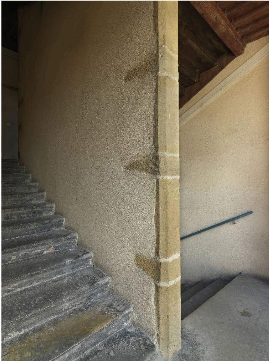
Vue du mur noyau et du dessous d'une des volées en bois depuis un repos de l'escalier du n°6 rue Dumenge
