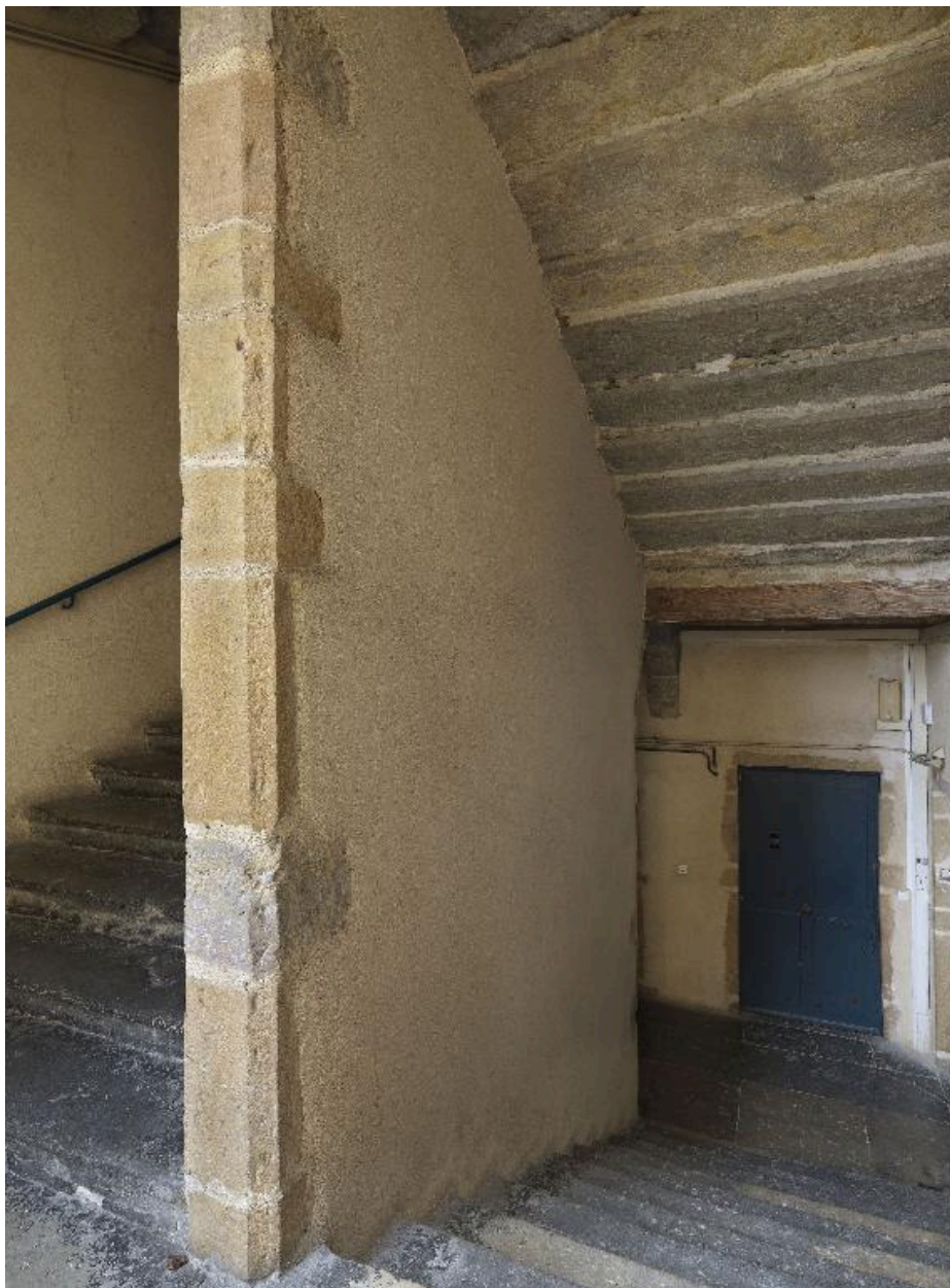
Vue du mur noyau depuis un repos intermédiaire de l'escalier du n°6 rue Dumenge
