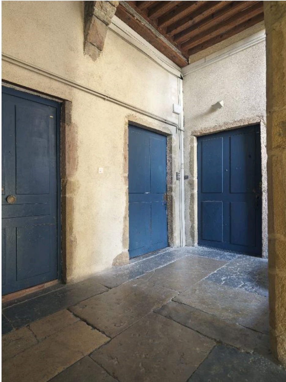
Vue d'un palier de l'escalier du n°6 rue Dumenge
