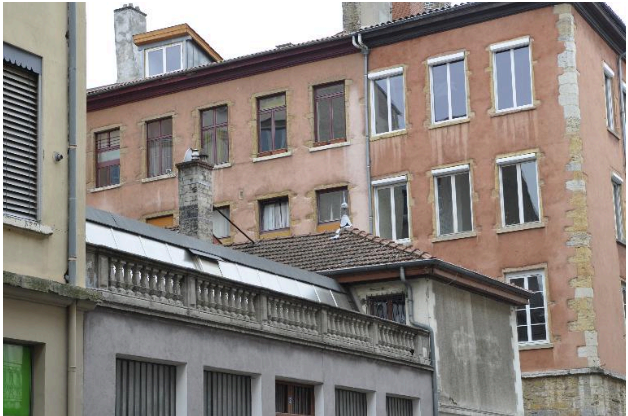
Deuxième et troisième étages du n°6 rue Dumenge sur la rue du Pavillon
