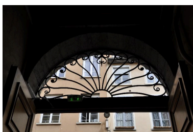
Imposte de la porte d'entrée de l'immeuble n°6 rue Dumenge et n°4 rue Dumenge Phot. Nadine Halitim-Dubois IVR82_20136900414NUCA
