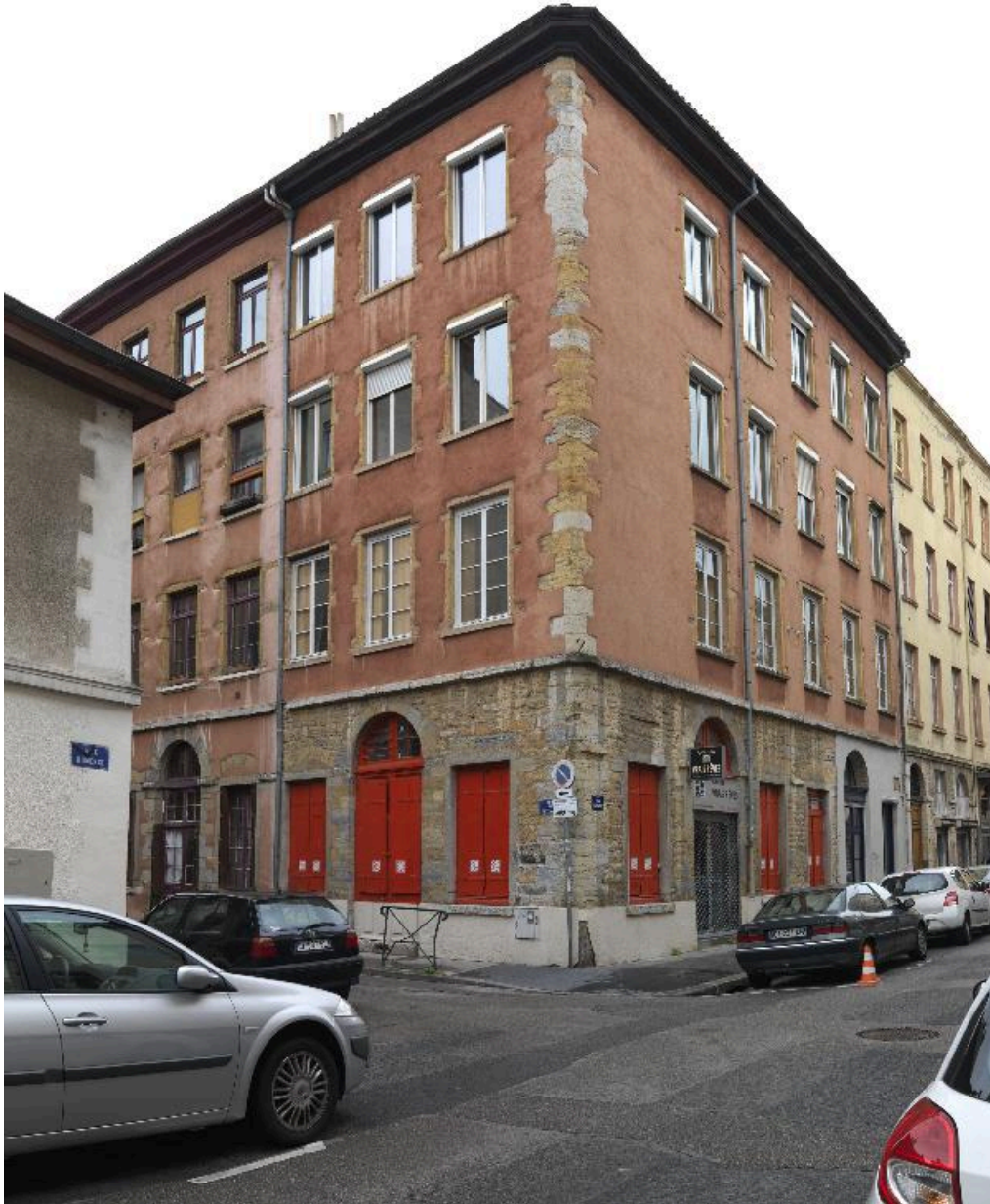
Vue d'ensemble du n°6 rue Dumenge depuis l'est
