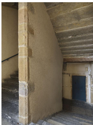
Vue du mur noyau depuis un repos intermédiaire de l'escalier du n°6 rue Dumenge Phot. Thierry_Leroy IVR82_20136901299NUCAQ
