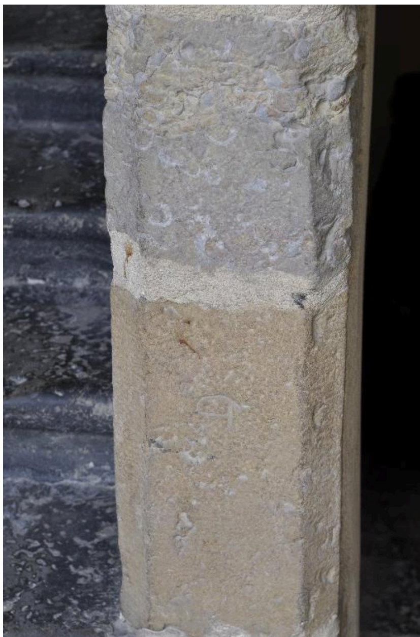
Marques lapidaires sur le mur noyau de l'escalier du n°6 rue Dumenge
