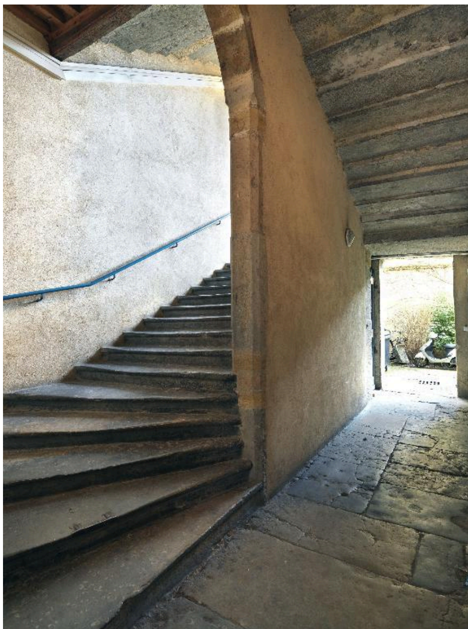
Départ de l'escalier du n°6 rue Dumenge
