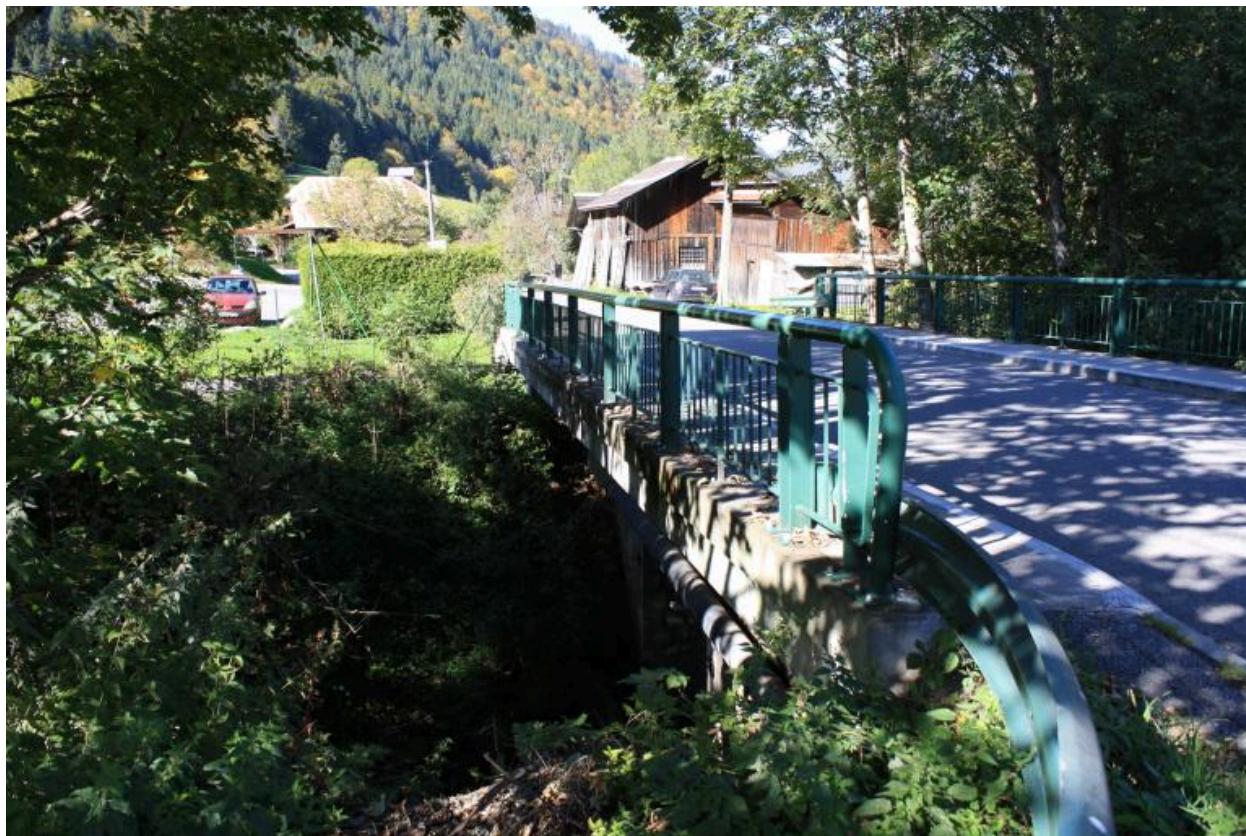
Pont d'Essert-Romand, chaussée et garde-corps
