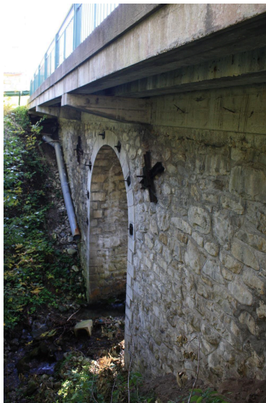
Pont d'Essert-Romand, face aval Phot. Benoît Huraut IVR84_20207401067NUCA
