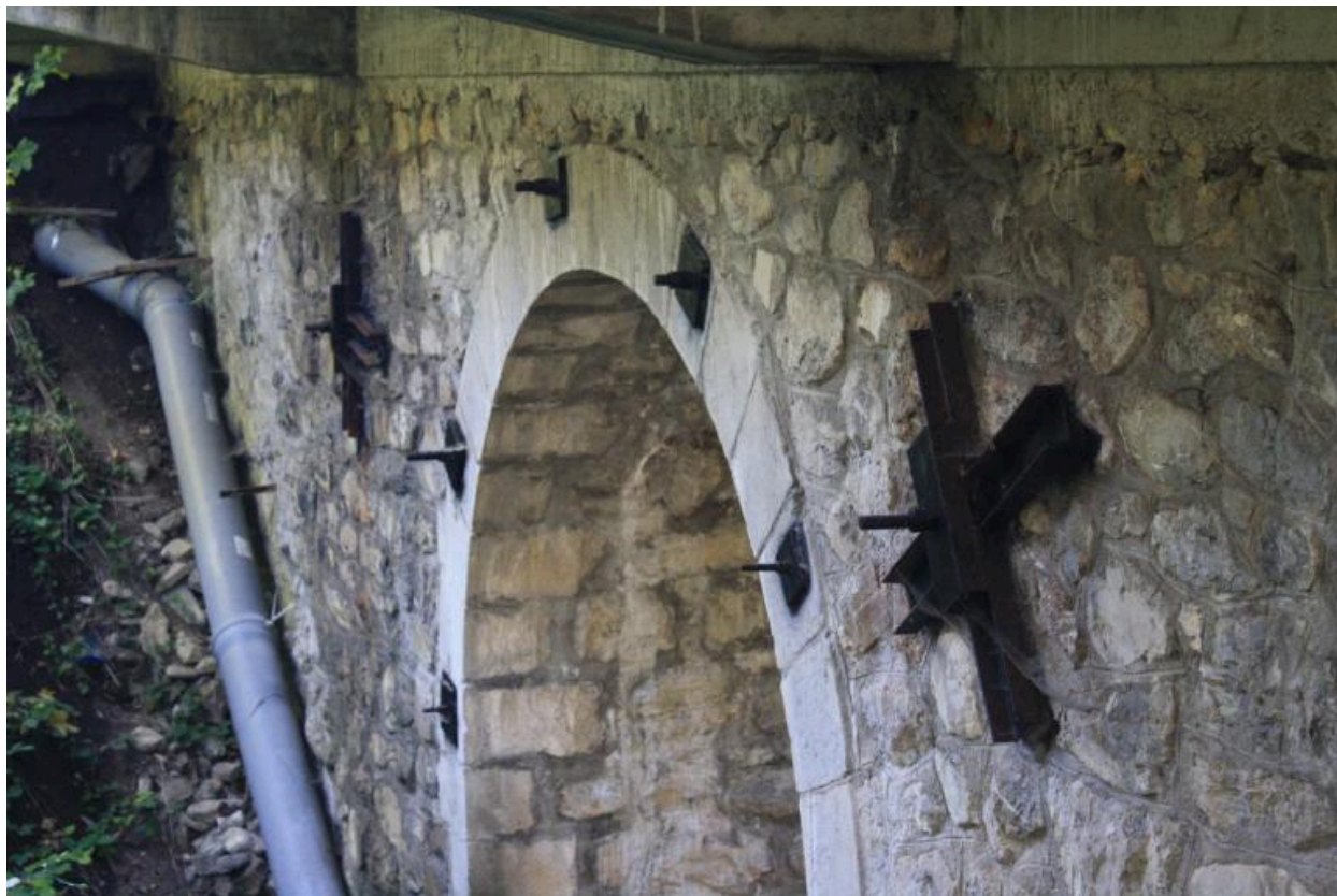
Pont d'Essert-Romand, détails bandeau et tirants d'enserrement
