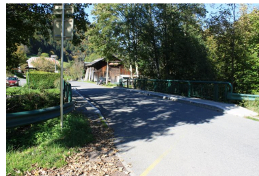
Pont d'Essert-Romand, contexte Phot. Benoît Huraut IVR84_20207401068NUCA
