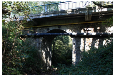
Pont d'Essert-Romand, face amont IVR84_20197401270NUCA
