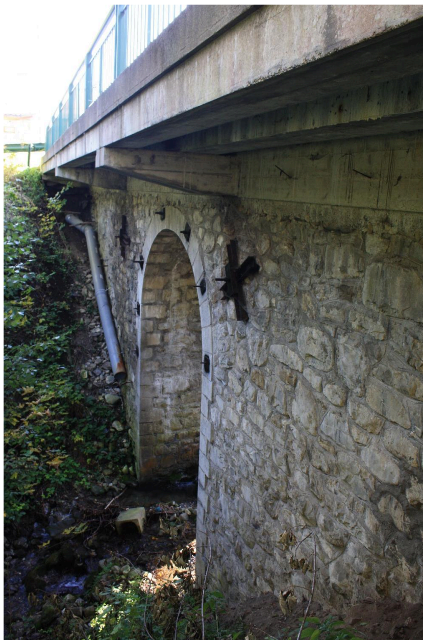
Pont d'Essert-Romand, face aval
