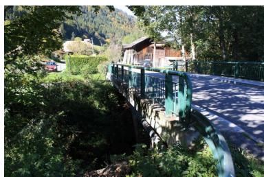
Pont d'Essert-Romand, chaussée et garde-corps Phot. Benoît Huraut IVR84_20207401069NUCA
