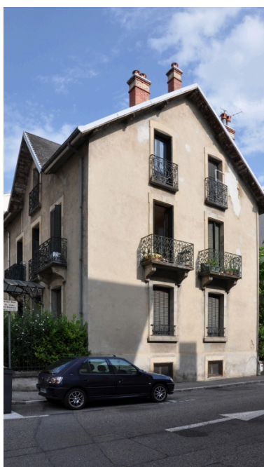
Élévation latérale droite Phot. François Fouger IVR82_20117300454NUCA
