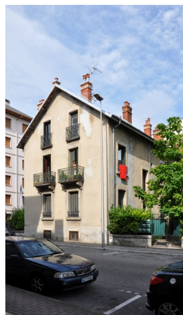
Élévation latérale gauche Phot. François Fouger IVR82_20117300455NUCA
