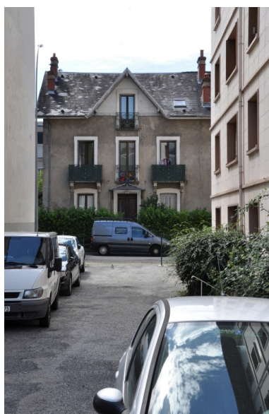
Façade de l'immeuble gauche Phot. François Fouger IVR82_20117300456NUCA
