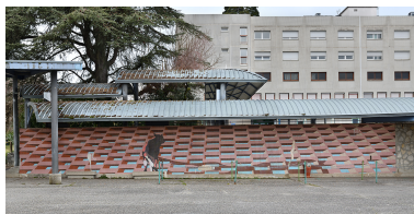
Vue d'ensemble Phot. Thierry Leroy IVR84_20230100025NUCAQ
