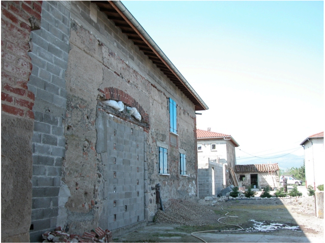
Vue du bâtiment sud, depuis l'est.
