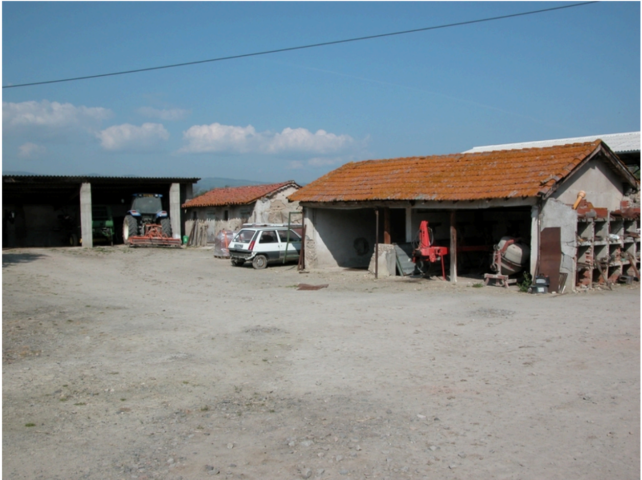
Vue de l'angle nord-ouest de la cour : hangar (à l'emplacement d'une porcherie), porcherie, ancien poulailler (transformé).
