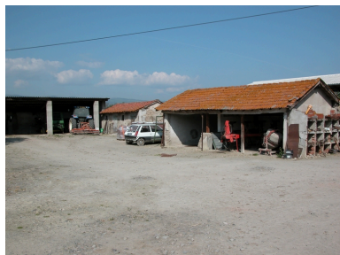
Vue de l'angle nord-ouest de la cour : hangar (à l'emplacement d'une porcherie), porcherie, ancien poulailler (transformé). Phot. Thierry Monnet IVR82_20134204232NUCA
