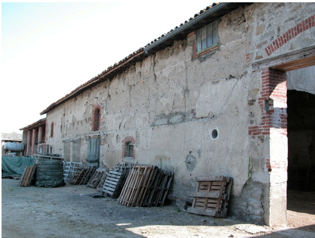
Vue de la grange-étable, depuis le sud-ouest.
