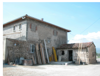
Vue de l'angle sud-ouest de la cour : laiterie, extrémité du bâtiment sud (reconstruite). Phot. Thierry Monnet IVR82_20134204234NUCA
