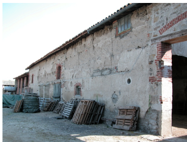
Vue de la grange-étable, depuis le sud-ouest. Phot. Thierry Monnet IVR82_20134204228NUCA
