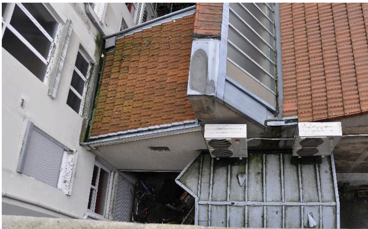
Cours du 36, rue Pasteur et du 7, rue de Bonald : loges de concierges en encorbellement
