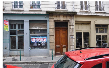
Elévation sur rue : vue rapprochée du rez-de-chaussée Phot. Magali Delavenne IVR82_20146902909NUCA
