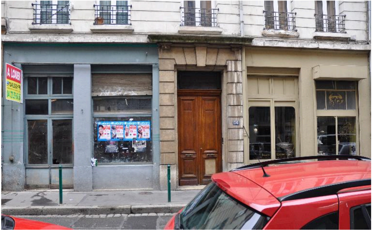
Elévation sur rue : vue rapprochée du rez-de-chaussée
