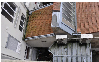
Cours du 36, rue Pasteur et du 7, rue de Bonald : loges de concierges en encorbellement Phot. Magali Delavenne IVR82_20146902915NUCA
