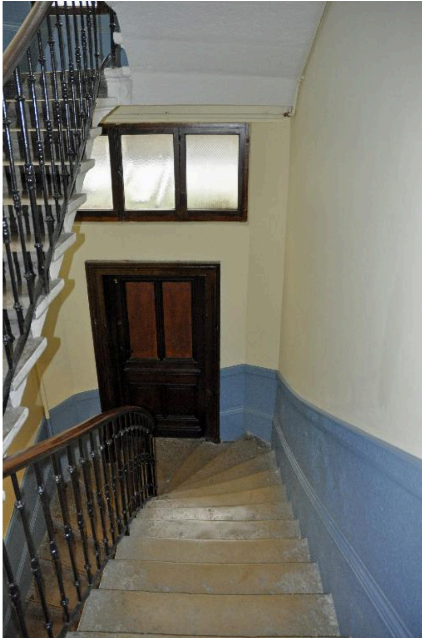
Vue intérieure : la première révolution de l'escalier
