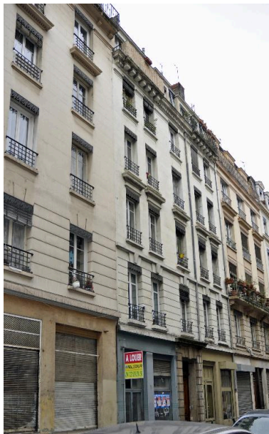
Elévation sur rue : vue générale Phot. Magali Delavenne IVR82_20146902908NUCA
