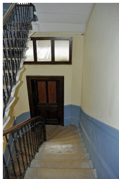
Vue intérieure : la première révolution de l'escalier Phot. Magali Delavenne IVR82_20146902912NUCA
