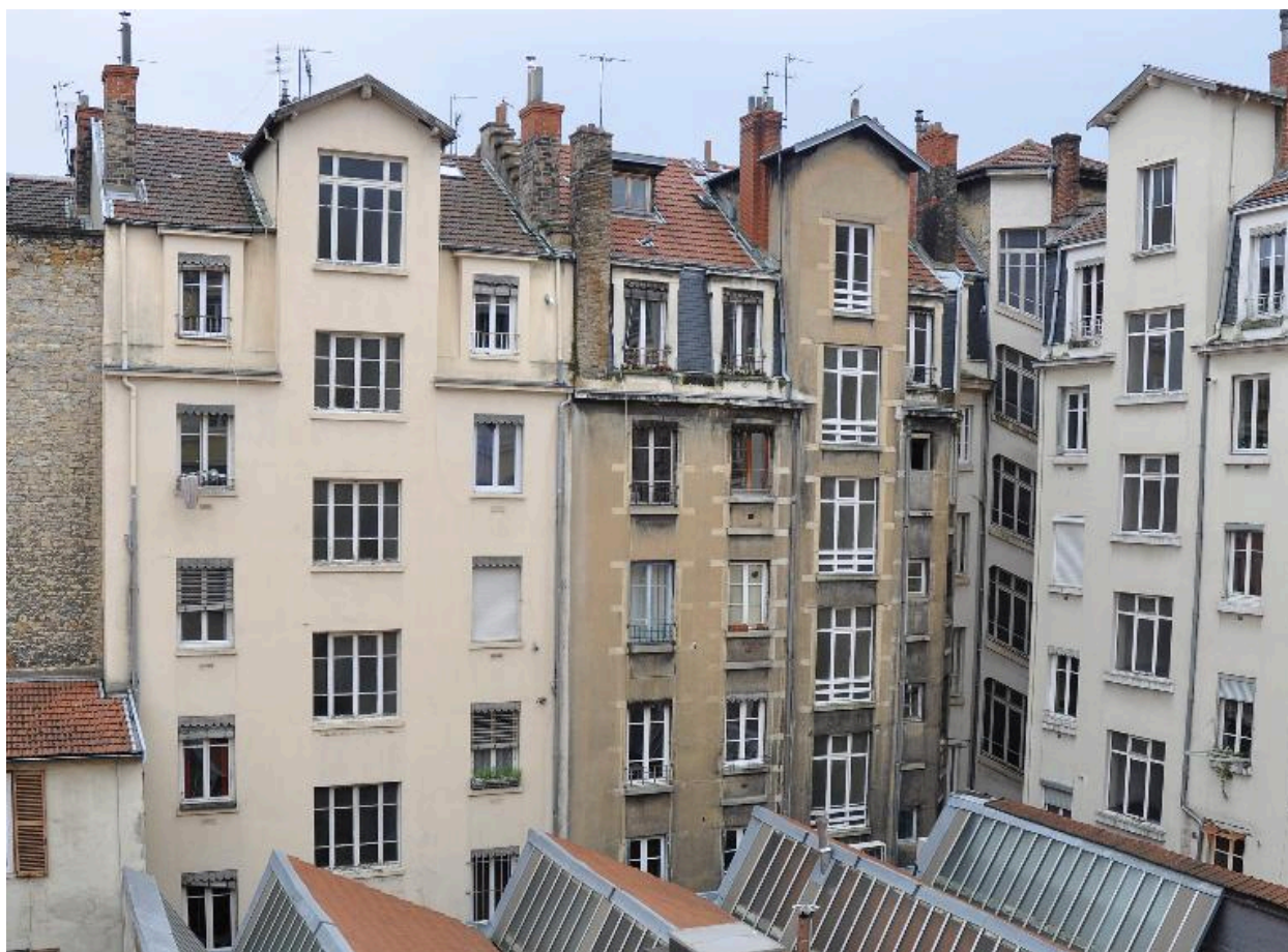
Elévation sur cour des 34-36, rue Pasteur
