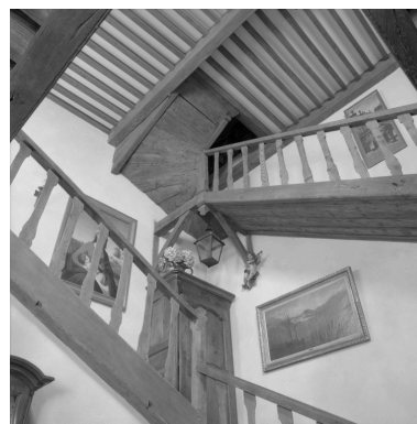
Vue d'ensemble de l'escalier.
