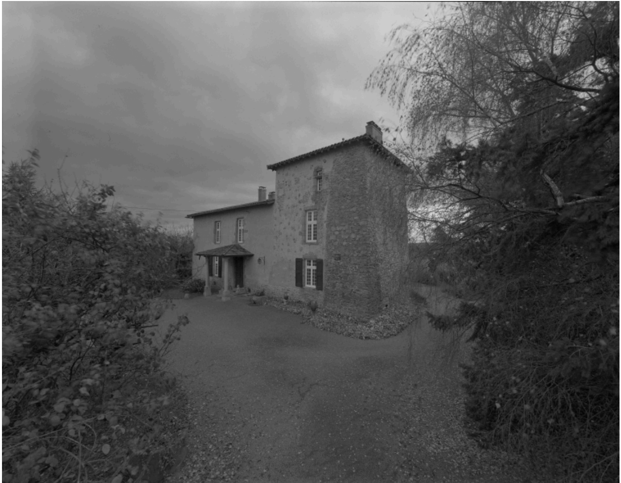
Vue générale de l'élévation principale.
