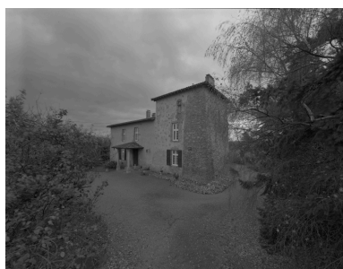
Vue générale de l'élévation principale. Phot. Eric Dessert IVR82_20034200580V
