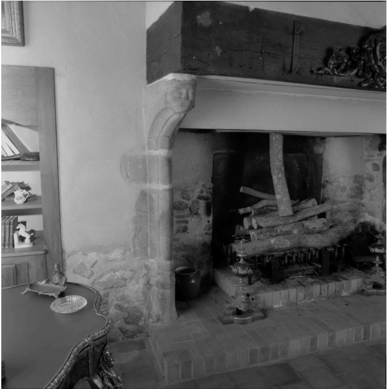
Détail d'un piédroit de la cheminée de la salle au rez-de-chaussée de la tour.
