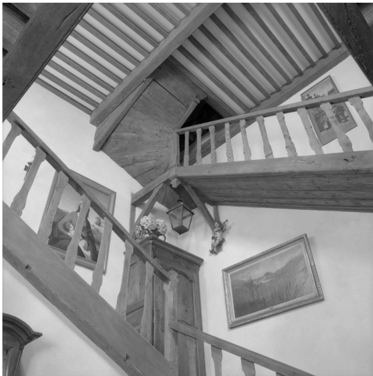
Vue d'ensemble de l'escalier.
