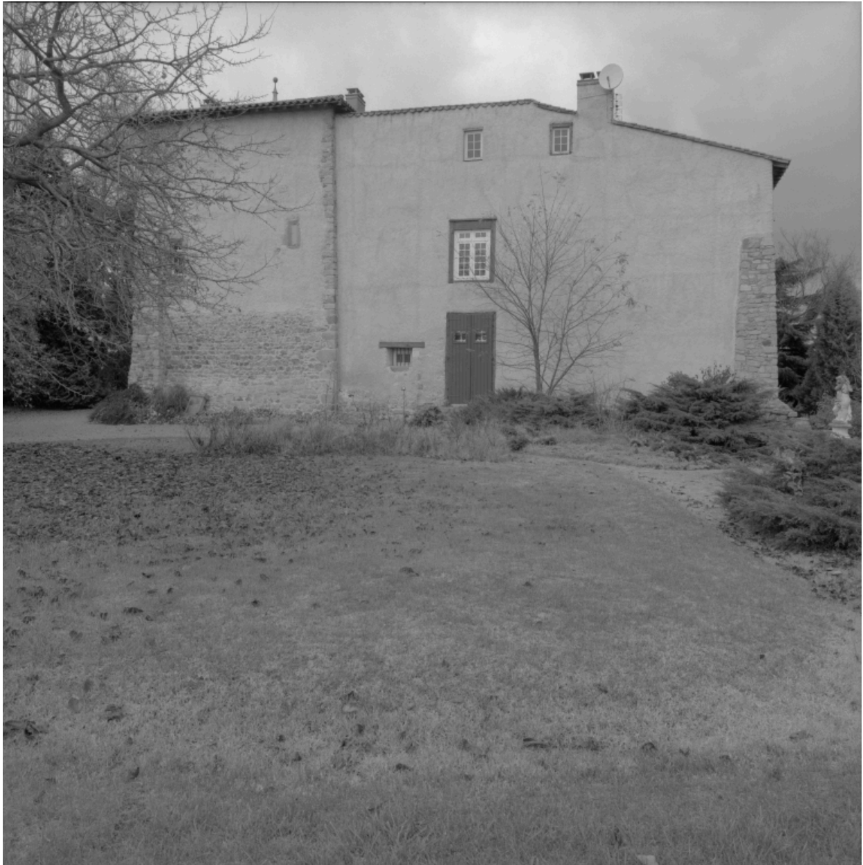
Vue d'ensemble de l'élévation postérieure.
