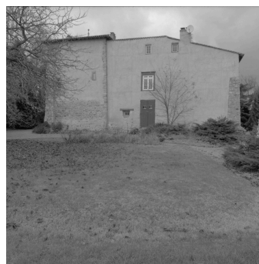
Vue d'ensemble de l'élévation postérieure. Phot. Eric Dessert IVR82_20034200581X
