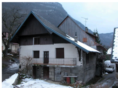
Vue générale. Phot. Jérôme Daviet IVR82_20107400969NUCA
