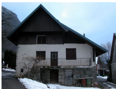
Vue de la façade principale en mur pignon Phot. Jérôme Daviet IVR82_20107400970NUCA
