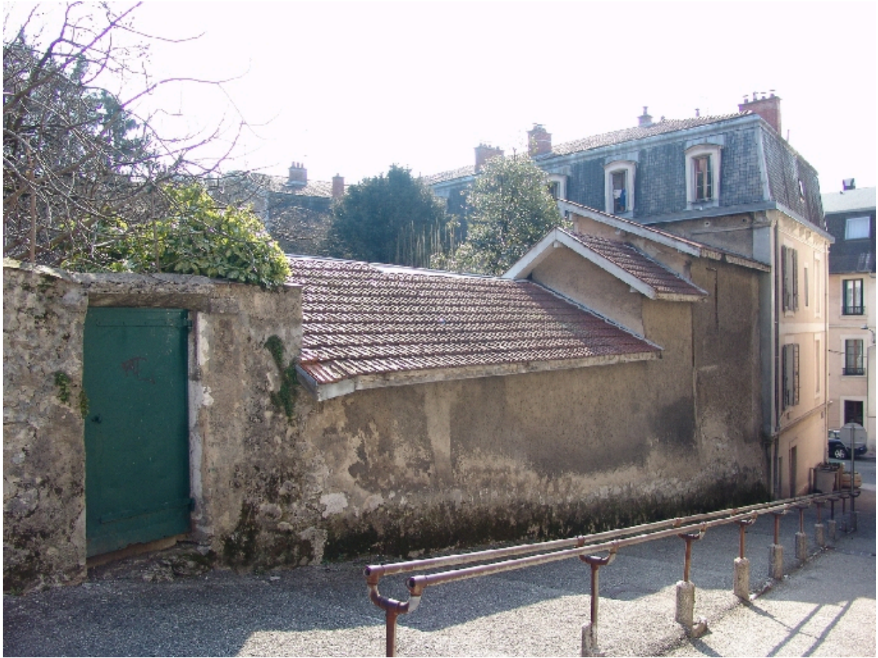
Vue d'ensemble depuis le haut
