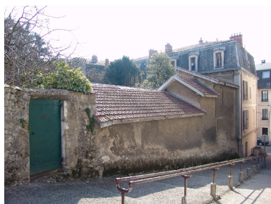
Vue d'ensemble depuis le haut Phot. François Fouger IVR82_20047300113NUCA
