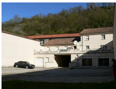
Façade arrière Phot. Isabelle Dupuis IVR82_20093800401NUCA
