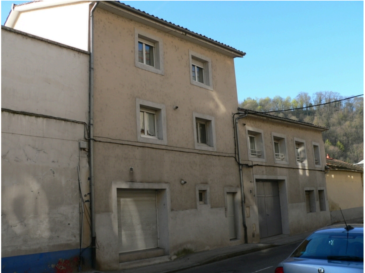
Façade principale sur rue
