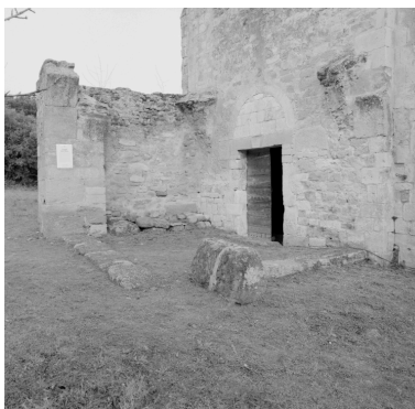
Vestiges du porche, devant la façade occidentale. Phot. Eric Dessert IVR82_20012600059X
