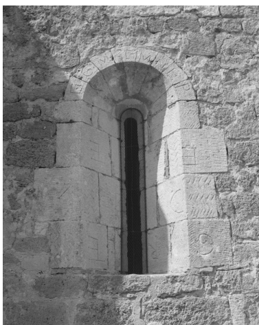
Elévation sud, détail : fenêtre de la 2e travée. Phot. Alain Franchella IVR82_19982600545X
