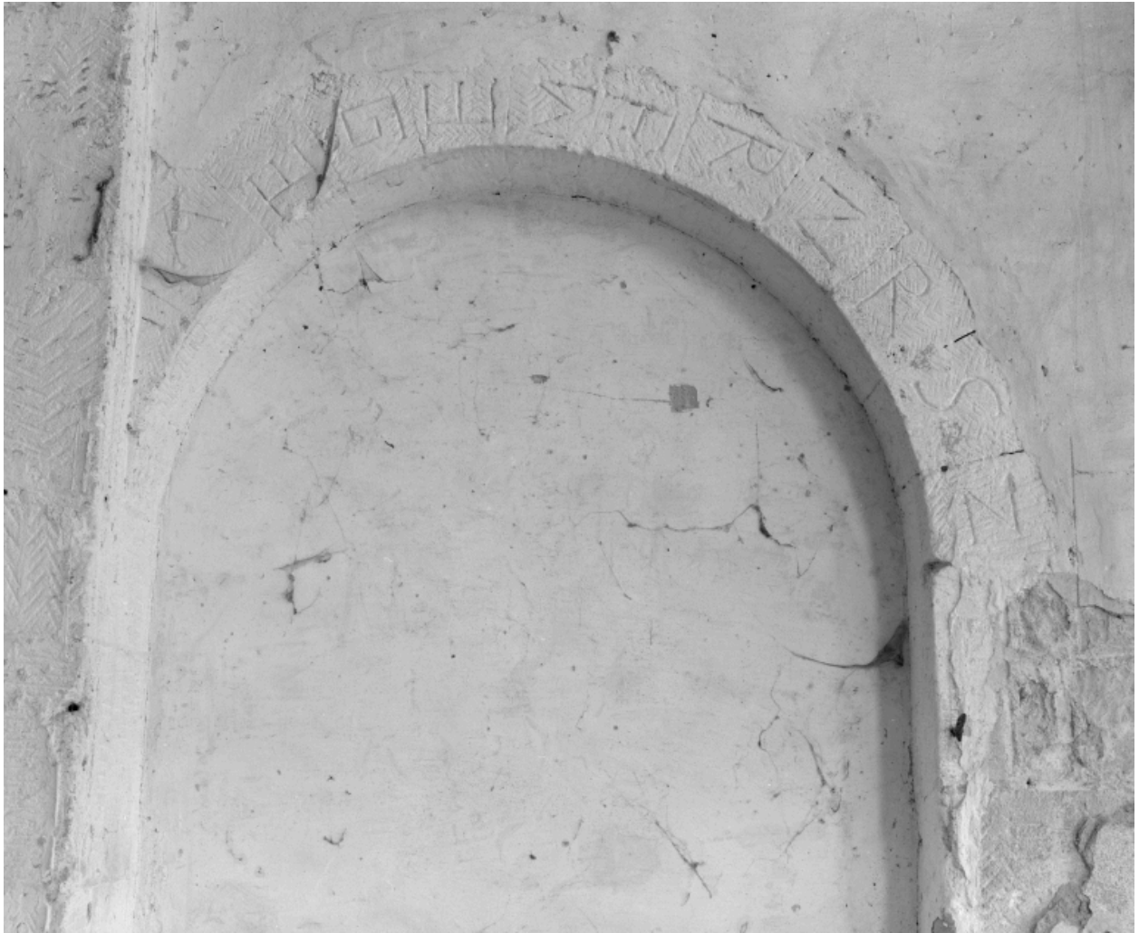
Nef, 1ère travée : arc de l'ancienne porte latérale droite, portant des marques de tâcherons
