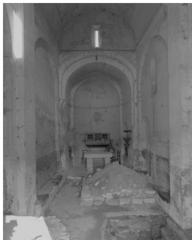
Vue intérieure, depuis l'entrée.
