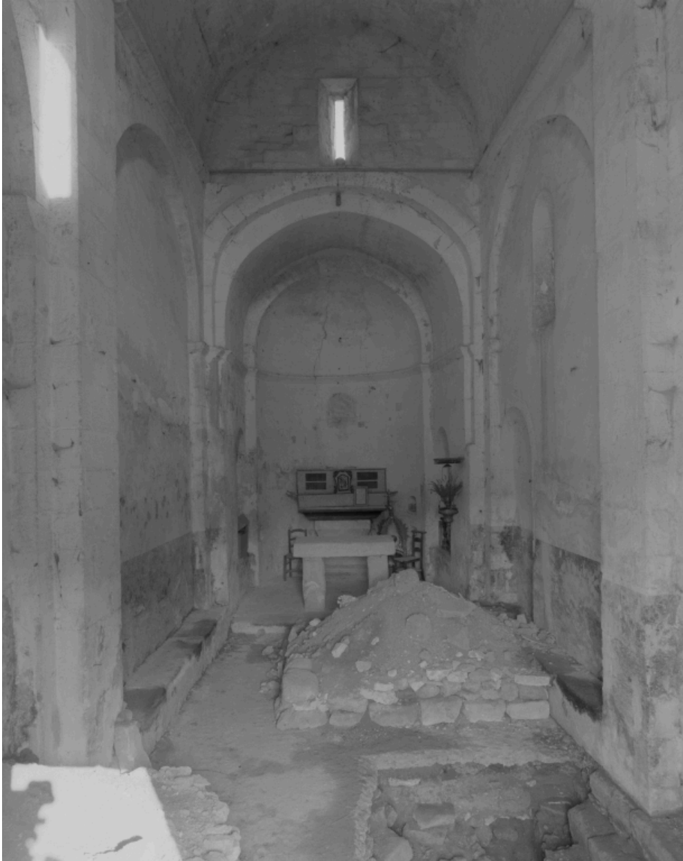
Vue intérieure, depuis l'entrée.
