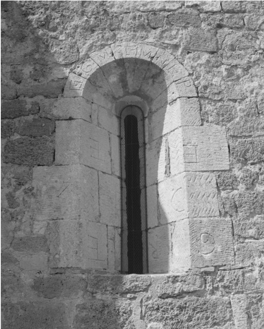
Elévation sud, détail : fenêtre de la 2e travée.
