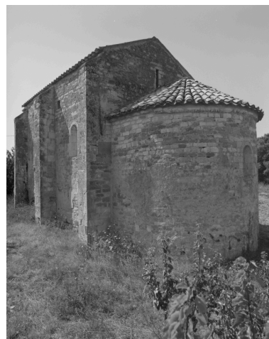
Vue d'ensemble prise du sud-est. Phot. Alain Franchella IVR82_19982600542X
