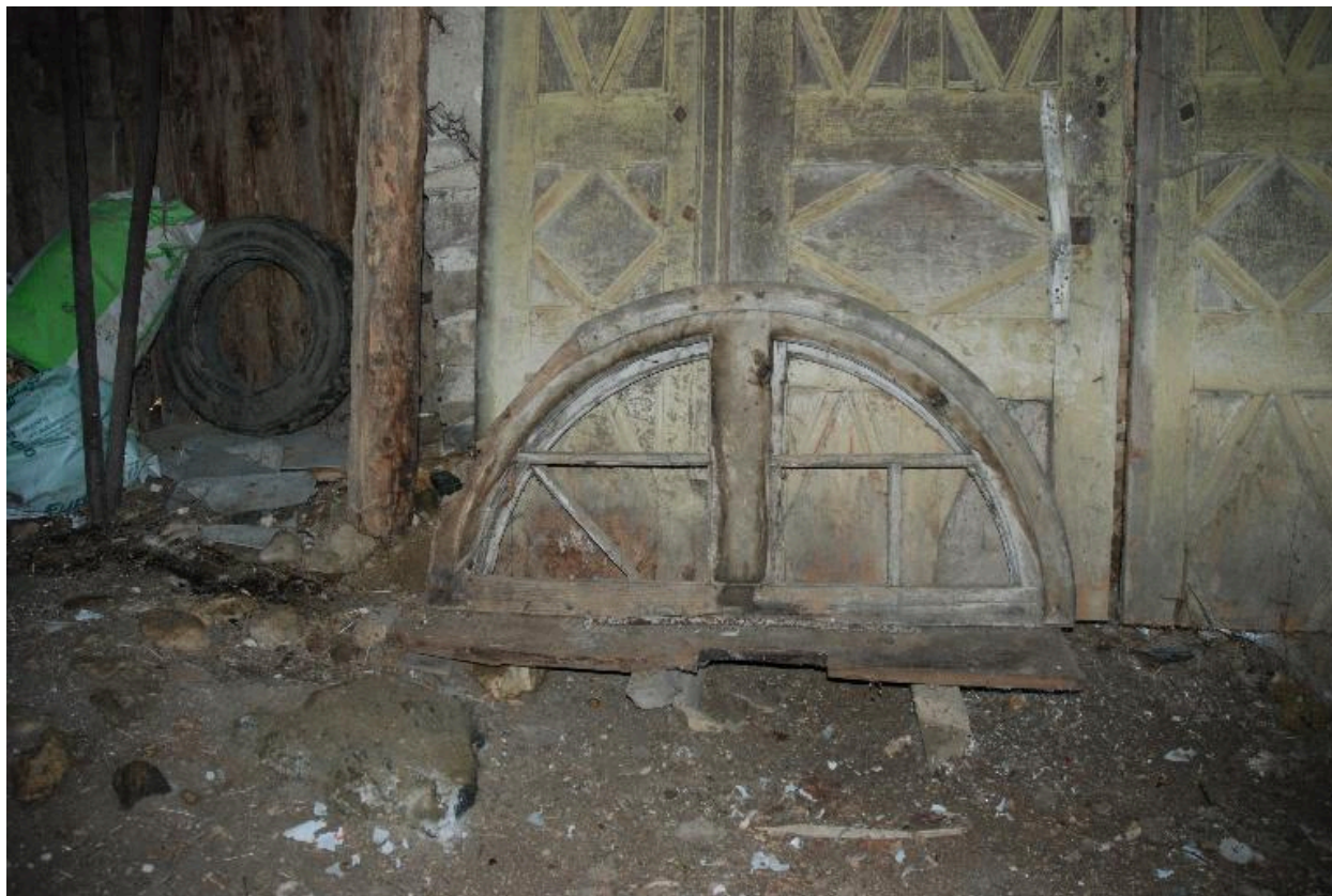
Vue de l'ancienne porte et de châssis de fenêtres de l'église (déposés).
