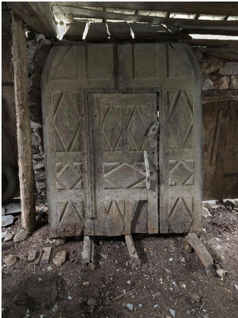
Vue de l'ancienne porte de l'église (déposée).
