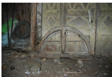
Vue de l'ancienne porte et de châssis de fenêtres de l'église (déposés). Phot. Thierry Monnet IVR82_20147302239NUCA
