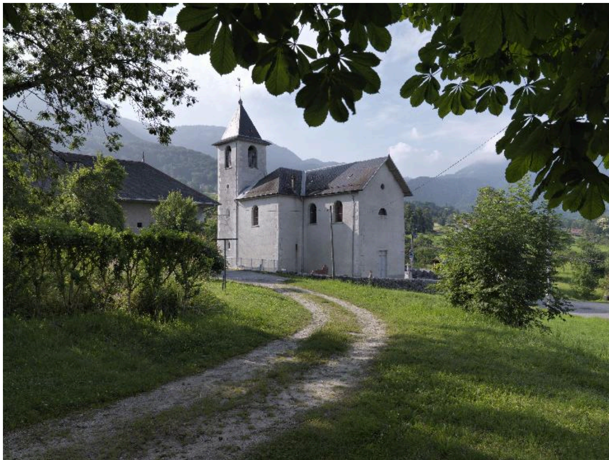
Vue générale depuis le nord-ouest.
