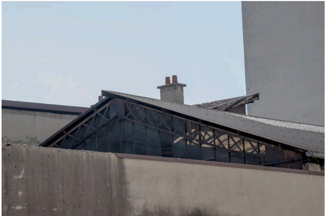
Vue sur la verrière de l'atelier depuis le nord-est
