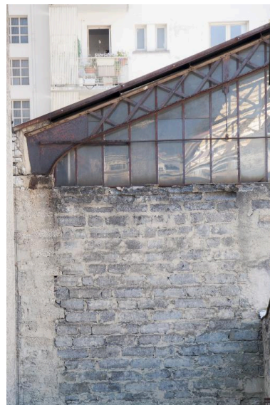
Vue sur la verrière de l'atelier depuis l'est Phot. Denys Harreau IVR82_20157301138NUCA
