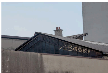
Vue sur la verrière de l'atelier depuis le nord-est Phot. Denys Harreau IVR82_20157301136NUCA
