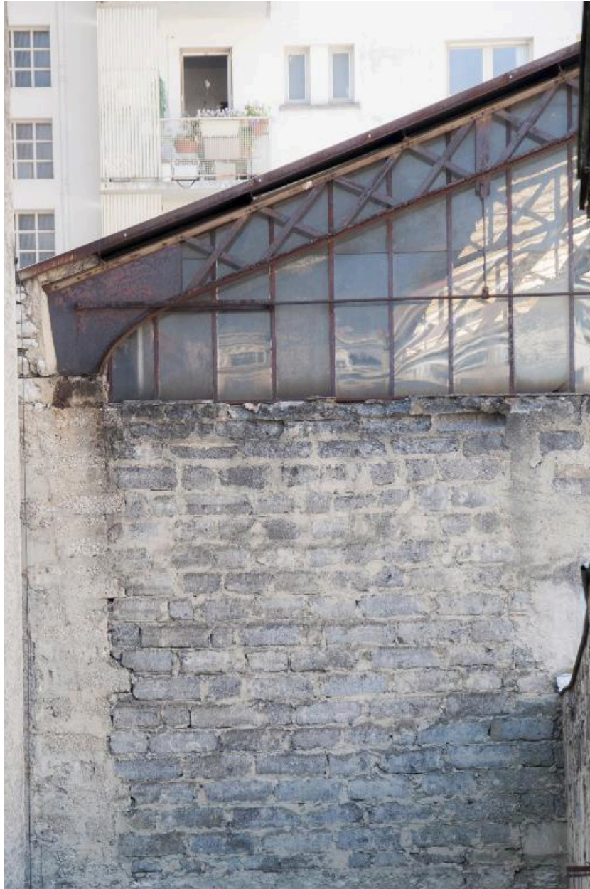
Vue sur la verrière de l'atelier depuis l'est
