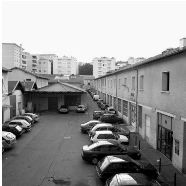
Vue nord de la cour intérieure Phot. Jean-Marie Refflé IVR82_20016903267X
