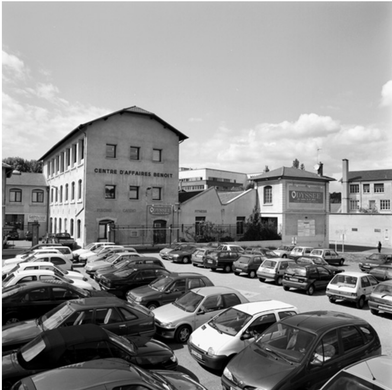
Vue d'ensemble est
