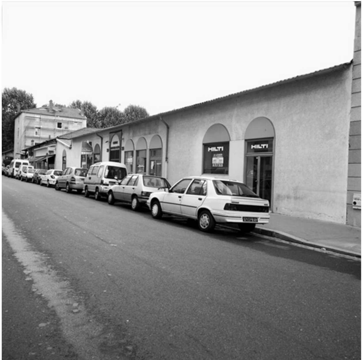
Vue sud-est de la rue Louis Loucheur
