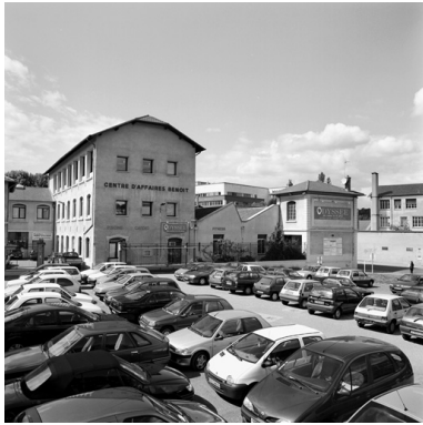
Vue d'ensemble est Phot. Jean-Marie Refflé IVR82_20016903264X
