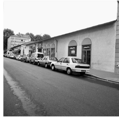
Vue sud-est de la rue Louis Loucheur Phot. Jean-Marie Refflé IVR82_20016903266X
