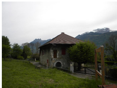
Vue d'ensemble. Phot. Jérôme Daviet IVR82_20147400147NUCA
