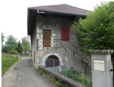
Vue de trois-quart depuis la route. Phot. Jérôme Daviet IVR82_20147400154NUCA
