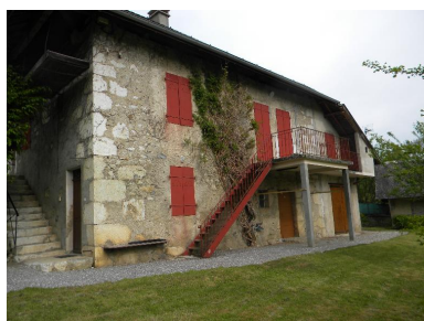
Vue du mur est. Phot. Jérôme Daviet IVR82_20147400156NUCA
