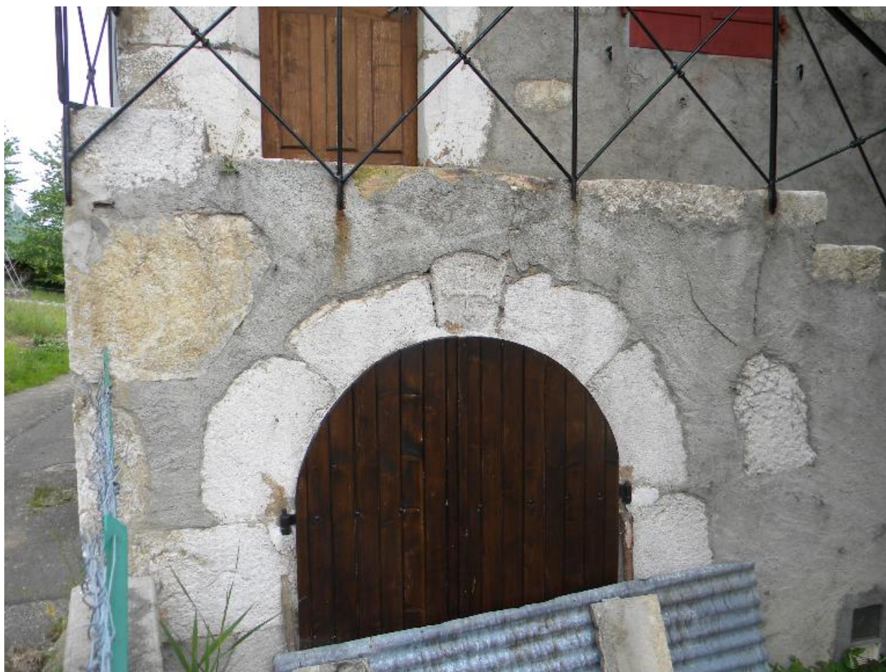
Entrée de cave sur la façade principale.
