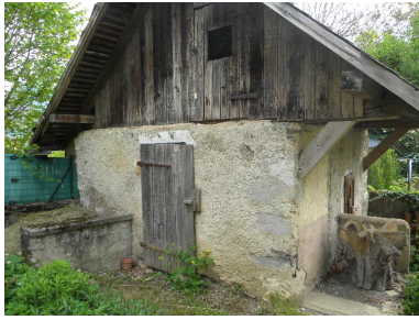
Vue de trois-quarts d'une dépendance. Phot. Jérôme Daviet IVR82_20147400165NUCA
