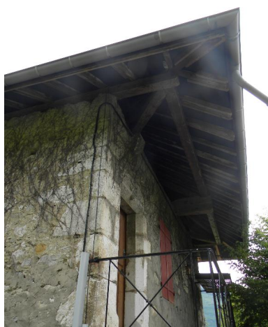
Vue de la charpente du débord de toit. Phot. Jérôme Daviet IVR82_20147400162NUCA
