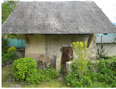
Vue de la façade sud d'une dépendance. Phot. Jérôme Daviet IVR82_20147400166NUCA
