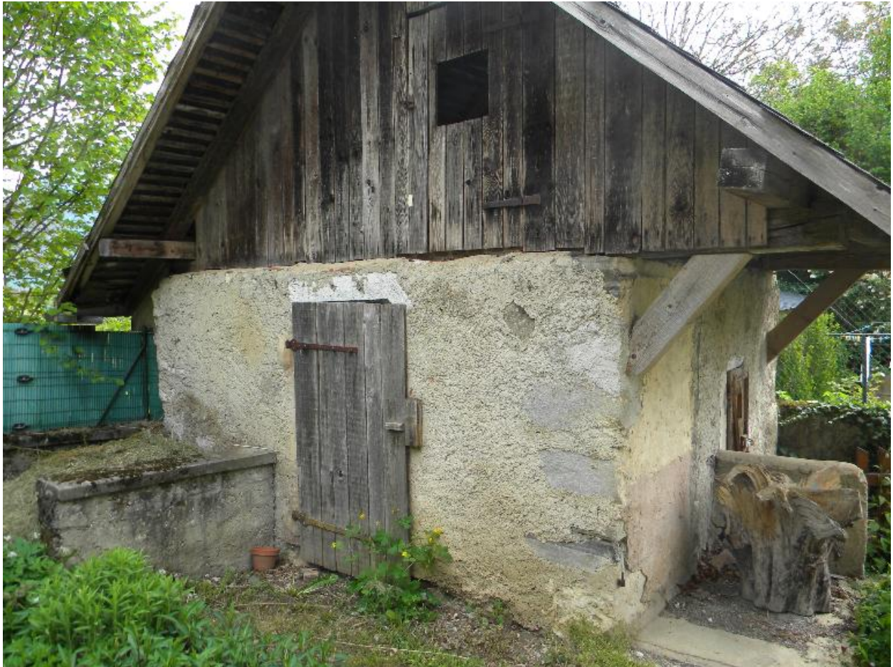
Vue de trois-quarts d'une dépendance.
