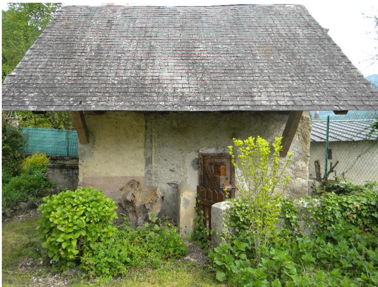
Vue de la façade sud d'une dépendance.
