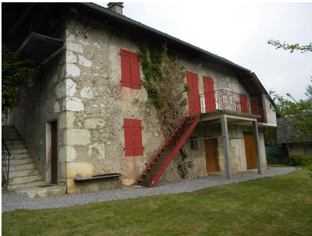
Vue du mur est.
