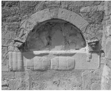
Porte méridionale, détail : vue du couvrement, arc orné de marques de tâcherons, de reliefs semi-méplats et de hauts-reliefs (linteau en remploi). Phot. Alain Franchella IVR82_19982600544X
