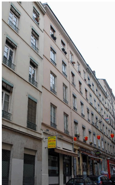
Vue d'ensemble, élévation sur rue Phot. Catherine Guégan IVR82_20156900974NUCA
