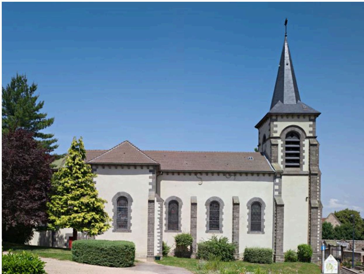
Vue générale nord.
