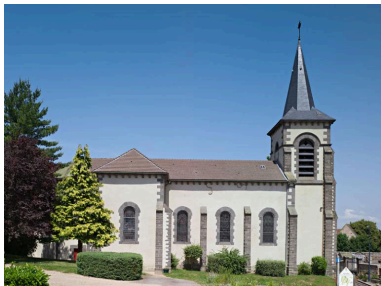
Vue générale nord. Phot. Jean-Michel Périn IVR83_20146300422NUC4A
