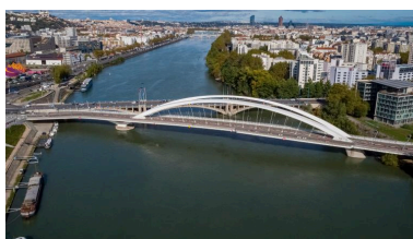
Vue sud du pont Raymond Barre (drône) Phot. Michel Pérès IVR84_20196900726NUCA
