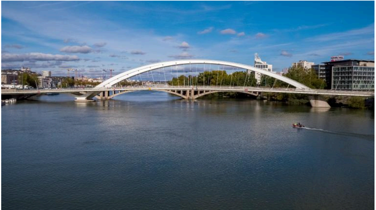
Vue sud du pont Raymond Barre (drône).
