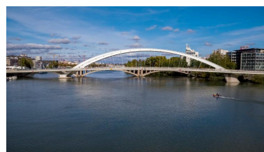
Vue sud du pont Raymond Barre (drône). Phot. Michel Pérès IVR84_20196900736NUCA
