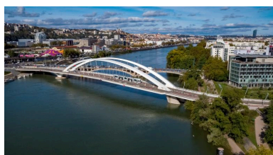
Vue du pont Raymond Barre (drône) Phot. Michel Pérès IVR84_20196900735NUCA
