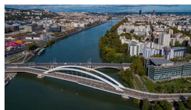
Vue du pont Raymond Barre et du pont Pasteur (drône). Phot. Michel Pérès IVR84_20196900728NUCA
