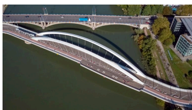
Vue des tabliers du pont Raymond Barre et du pont Pasteur (drône). Phot. Michel Pérès IVR84_20196900733NUCA
