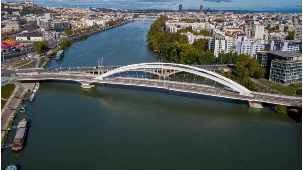
Vue sud du pont Raymond Barre (drône)
