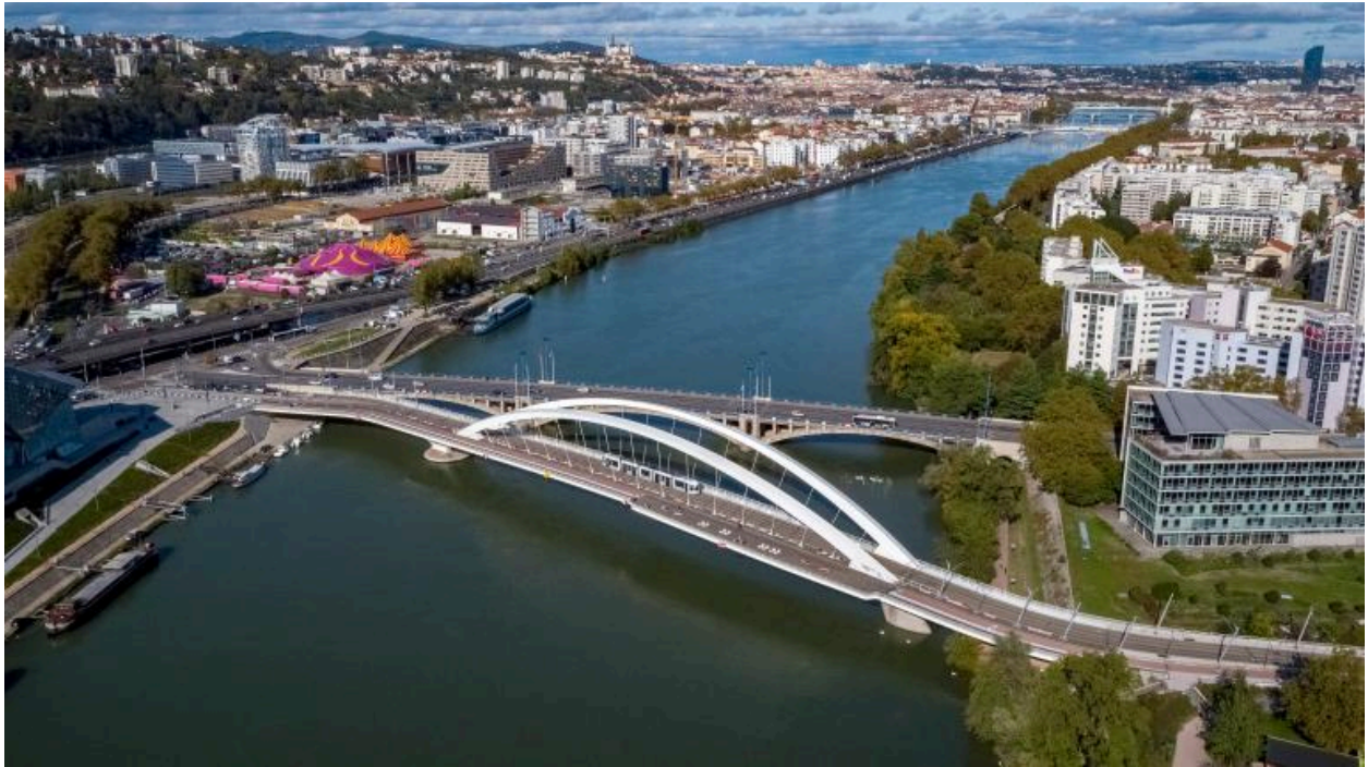
Vue sud-est du pont Raymond Barre (drône).
