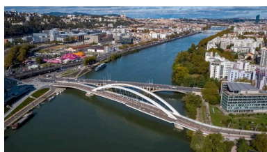
Vue sud-est du pont Raymond Barre (drône). Phot. Michel Pérès IVR84_20196900732NUCA
