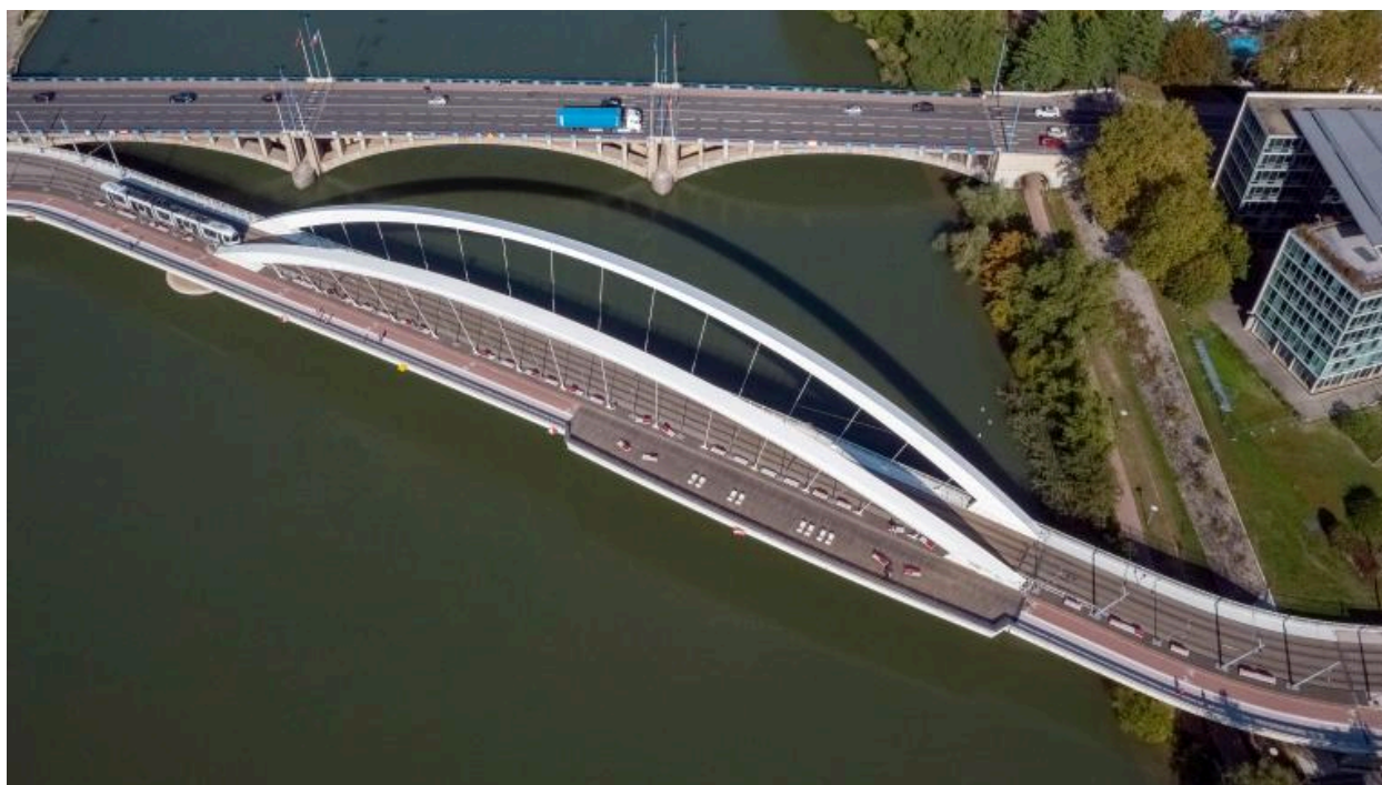
Vue des tabliers du pont Raymond Barre et du pont Pasteur (drône).
