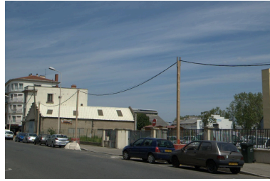
Vue sud-ouest Phot. Nadine Halitim-Dubois IVR82_20086900458NUCA
