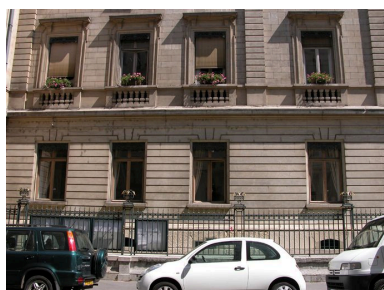
Détail de l'élévation rue Franklin Phot. Bernard Ducouret IVR82_20046901172NUCA
