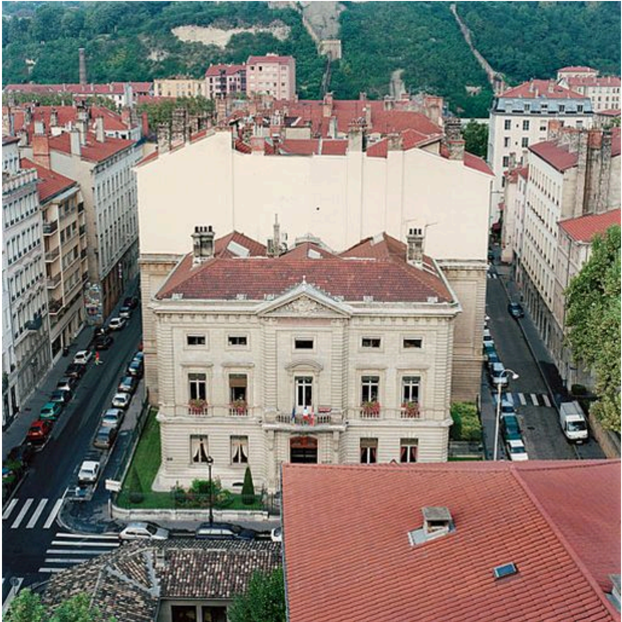
Vue générale de l'édifice prise du toit du central téléphonique Ampère
