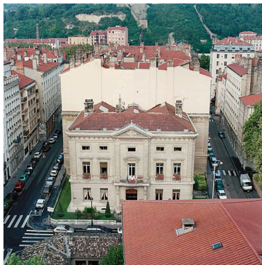
Vue générale de l'édifice prise du toit du central téléphonique Ampère Phot. Eric Dessert IVR82_20046901225XE
