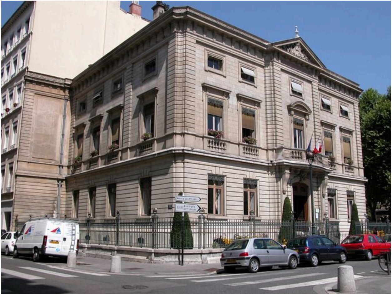
Vue générale sur l'angle des rues Franklin et d'Enghien
