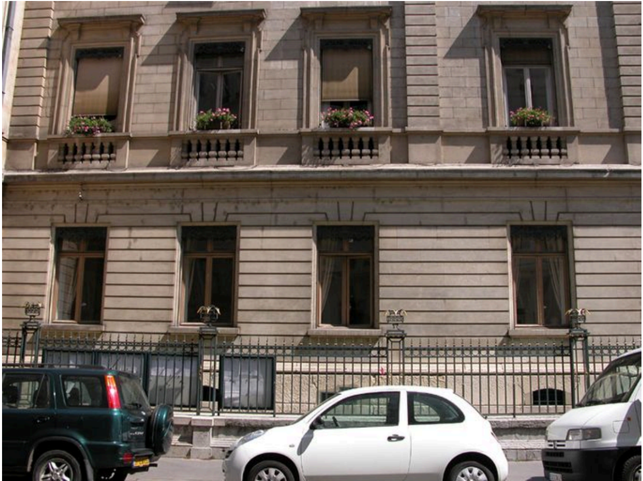
Détail de l'élévation rue Franklin
