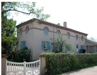
Vue d'ensemble côté cour. Phot. Thierry Monnet IVR82_20134204237NUCA
