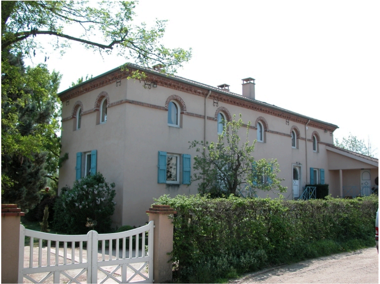
Vue d'ensemble côté cour.
