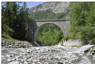
Vue de la face amont du viaduc de Mont-Roc et de son arche principale Phot. Samir Mahfoudi IVR84_20197401180NUCA
