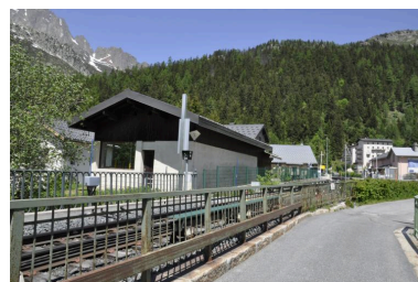
Voie ferrée et chaussée routière séparées par des gardes corps métalliques Phot. Samir Mahfoudi IVR84_20197401185NUCA
