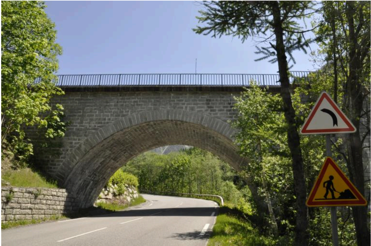
Vue de la face aval de l'arche enjambant la route Roger Fournier
