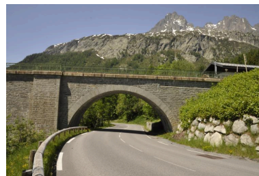
Vue de la face amont de l'arche surplombant la route Roger Fournier Phot. Samir Mahfoudi IVR84_20197401182NUCA
