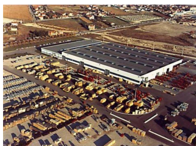
Vue d'ensemble du site de Saint-Priest (archive Fondation Berliet) Phot. Nadine Halitim-Dubois IVR84_20216900015NUCA
