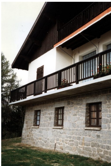
Elévation ouest. Etat en 1995 Phot. F. Véry IVR82_20127402171NUCA
