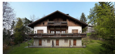
Façade principale à l'ouest Phot. Eric Dessert IVR82_20107401607NUCA
