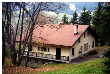
Vue depuis le sud-est. Etat en 1995 Phot. F. Véry IVR82_20127401678NUCA
