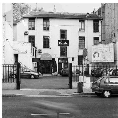
Vue générale sud
