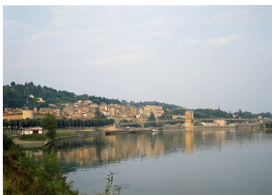
Vue d'ensemble prise en amont, depuis la rive droite de la Saône.
