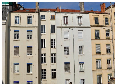
Vue partielle des élévations sur cour Phot. Magali Delavenne IVR82_20146902768NUCA
