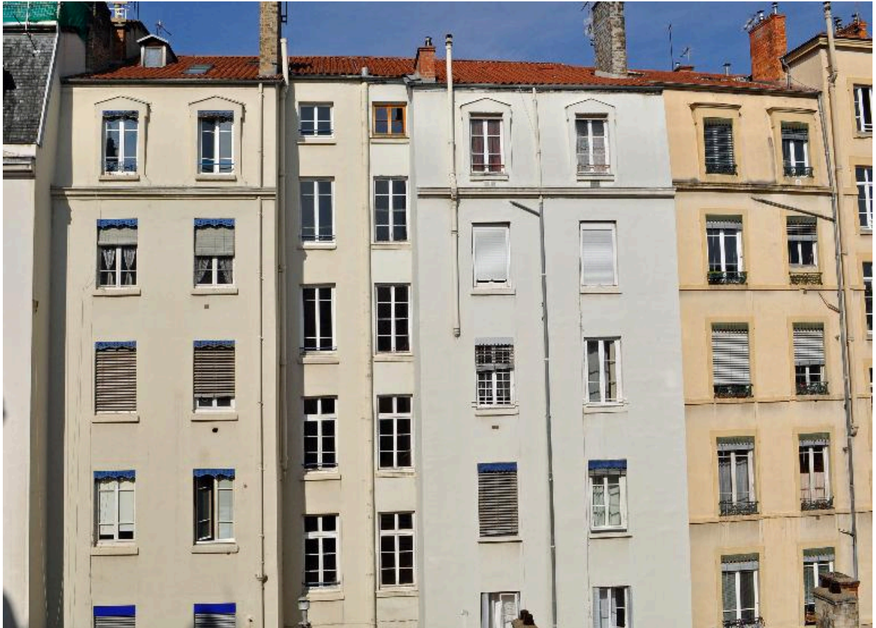
Vue partielle des élévations sur cour
