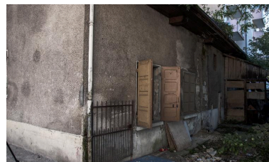
Élévation postérieure, vue prise du nord-est Phot. Denys Harreau IVR82_20157301058NUCA
