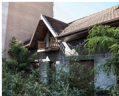
Élévation principale, vue prise du sud-est Phot. Denys Harreau IVR82_20157301057NUCA
