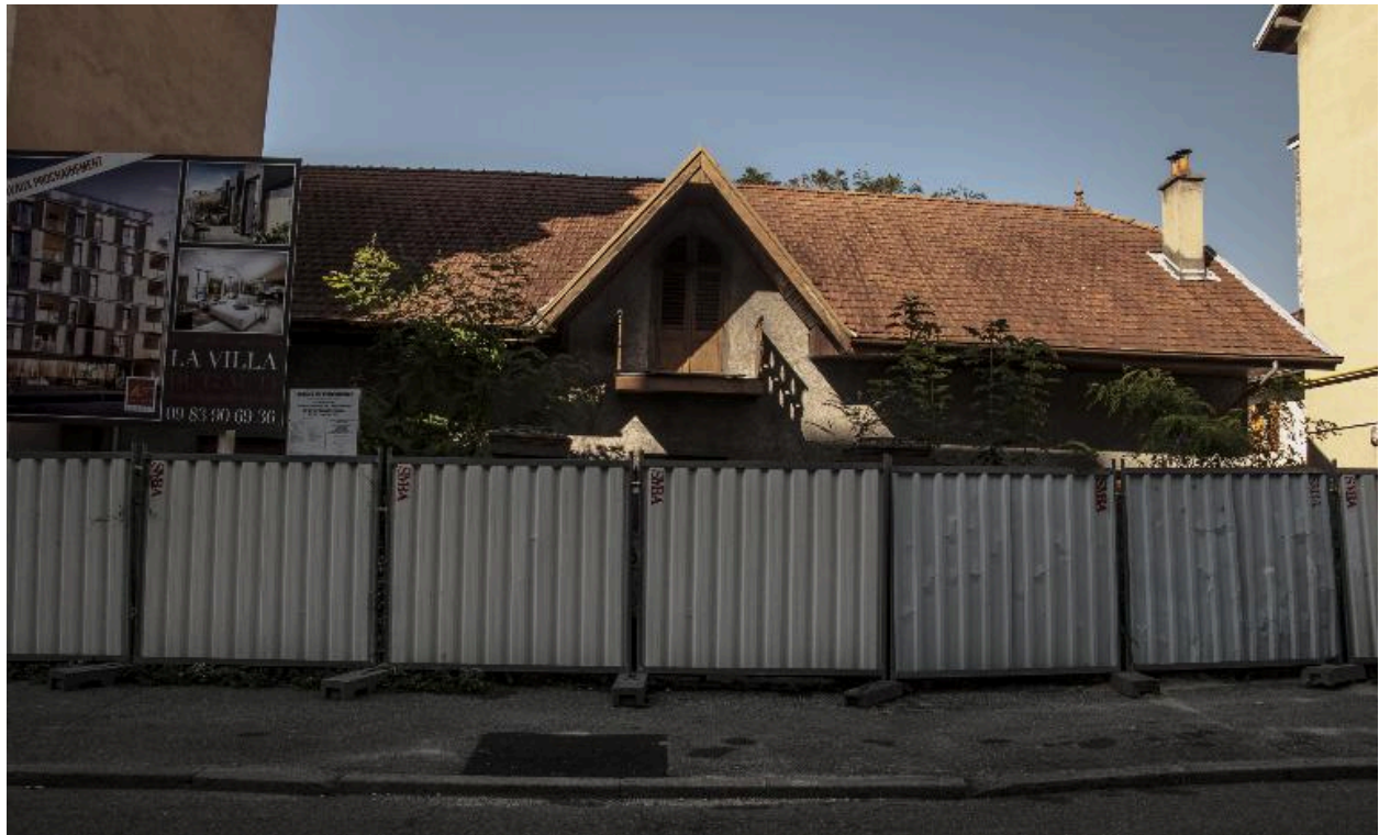
Vue générale depuis le sud
