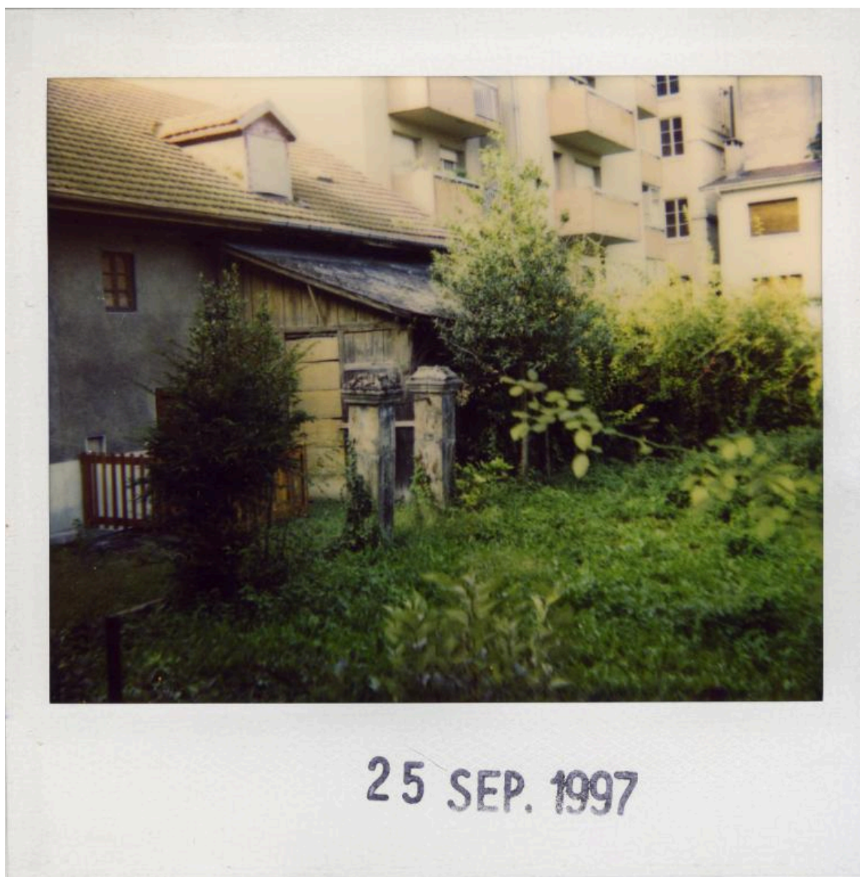
Façade postérieure et jardin, 1997
