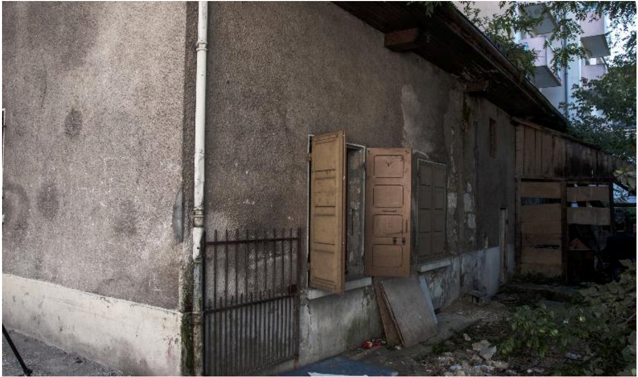
Élévation postérieure, vue prise du nord-est
