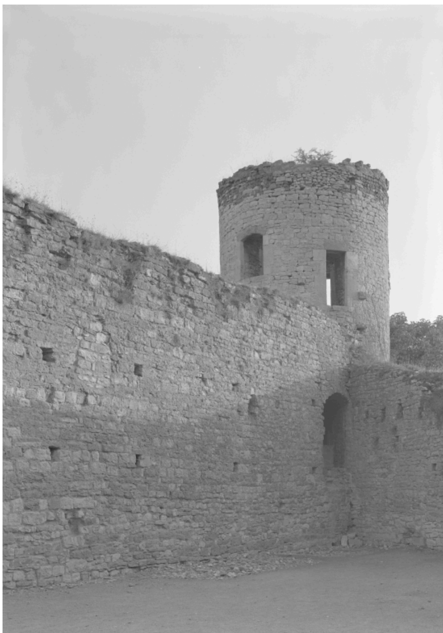
Mur et tour de fortification, dite la tour ronde.
