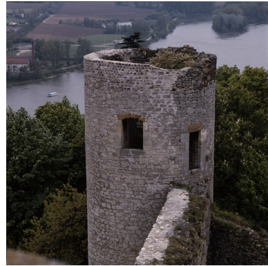
La Tour ronde vue depuis le nord. Phot. Eric Dessert IVR82_19910100553XA
