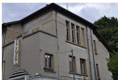
Détail des ouvertures de l'élévation sud. Phot. Catherine Guillot IVR82_20116902186NUCA
