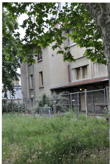
Vue de l'élévation est. Phot. Catherine Guillot IVR82_20116902189NUCA
