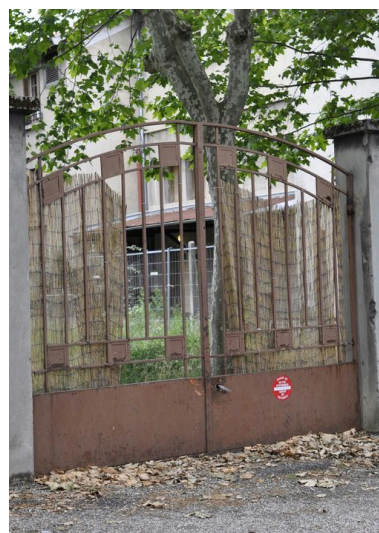
Détail du portail, situé allée du Château Montchat, à l'arrière de la parcelle, au nord. Phot. Catherine Guillot IVR82_20116902188NUCA
