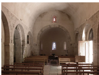
Vue intérieure, vers l'est (abside du 13e siècle). Phot. Thierry Monnet IVR82_20094200154NUCA
