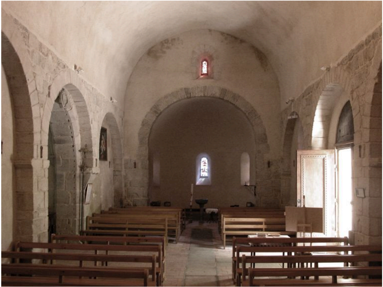
Vue intérieure, vers l'est (abside du 13e siècle).
