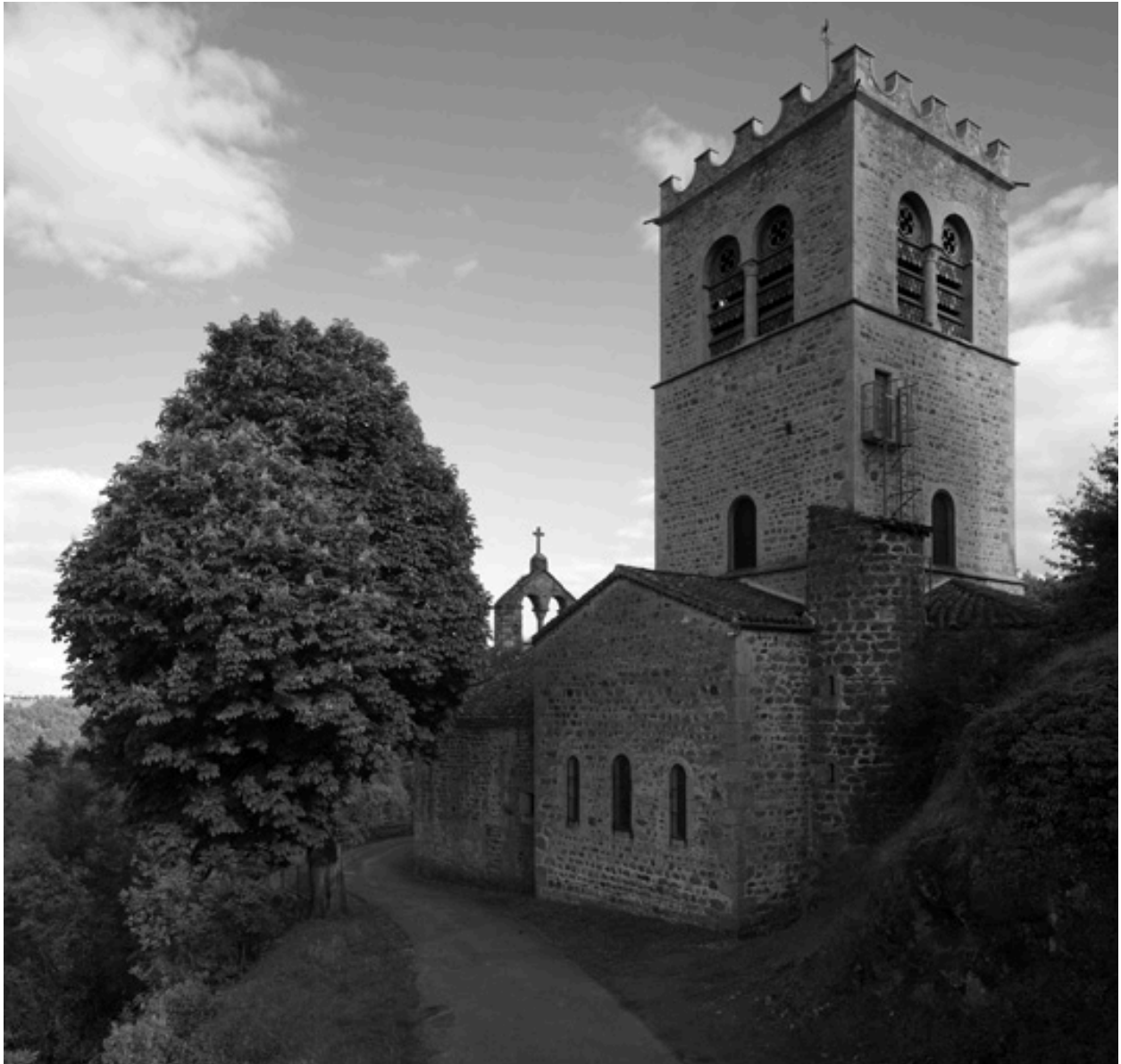
Vue d'ensemble de l'église depuis le nord-ouest.
