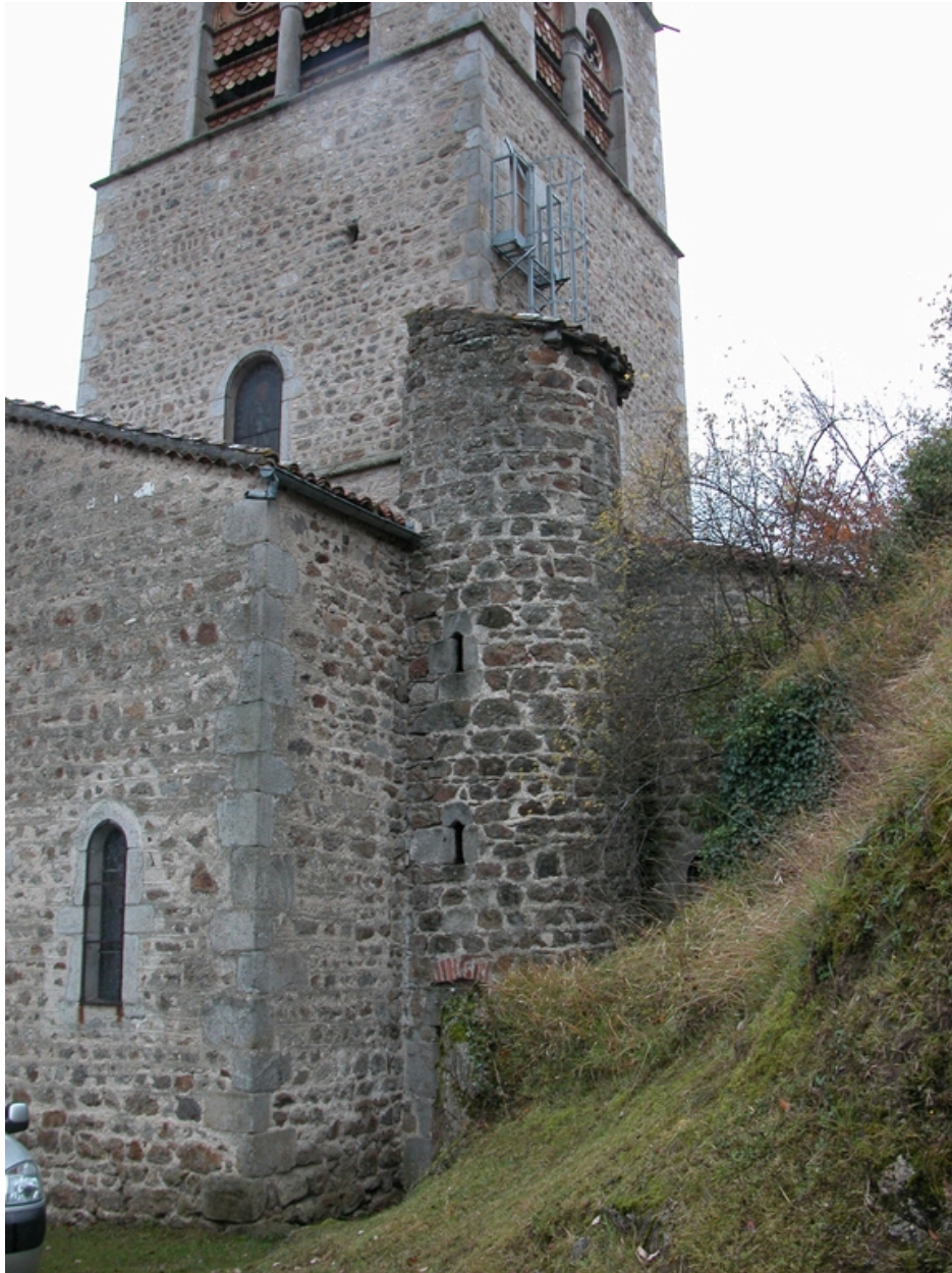
Vue du chevet occidental, depuis le nord-ouest : escalier du clocher.
