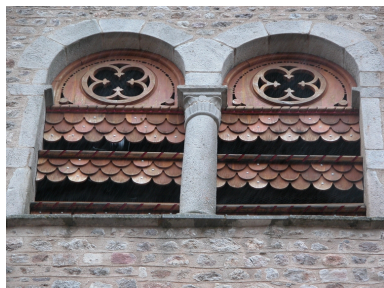
Vue de la tour clocher depuis le nord : étage du beffroi. Phot. Caroline Guibaud IVR82_20124201714NUCA
