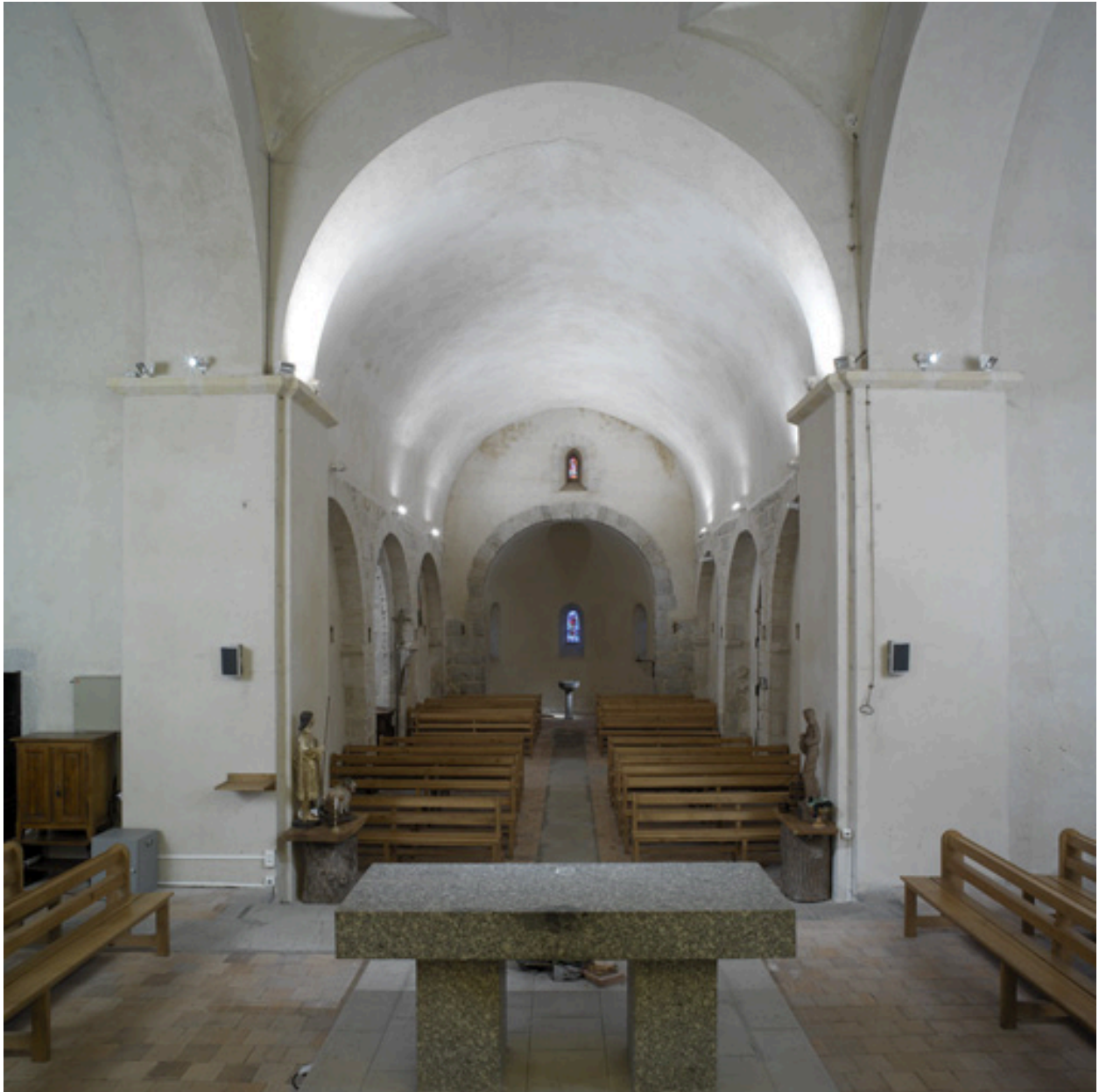
Vue intérieure, vers l'est (abside du 13e siècle).
