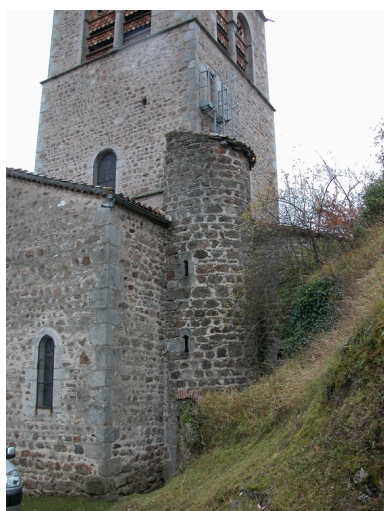
Vue du chevet occidental, depuis le nord-ouest : escalier du clocher. Phot. Caroline Guibaud IVR82_20124201715NUCA
