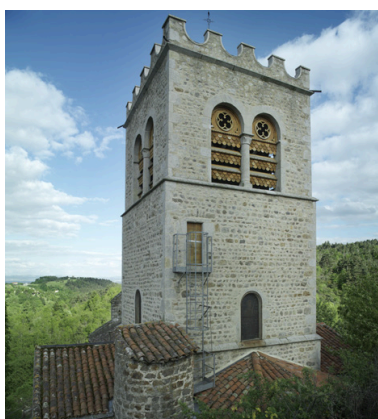
Vue de la tour clocher depuis le nord-ouest. Phot. Didier Gourbin IVR82_20054201935NUCA
