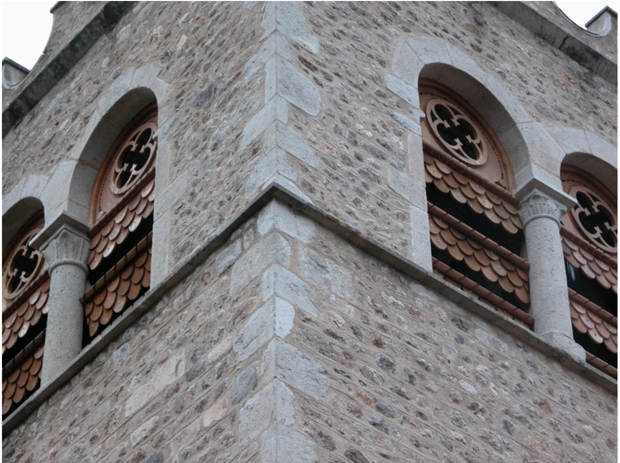
Vue de la tour clocher depuis le sud-est : étage du beffroi.
