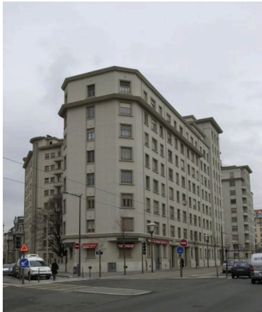
Vue de l'élévation avenue Berthelot depuis l'ouest Phot. Anaïs Beccaria IVR82_20046903521NUCA
