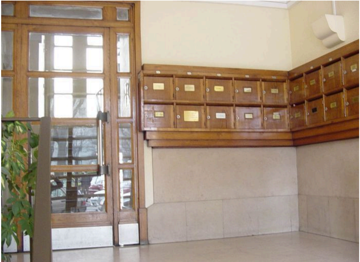
Vestibule-sas (14 place Jean-Macé)
