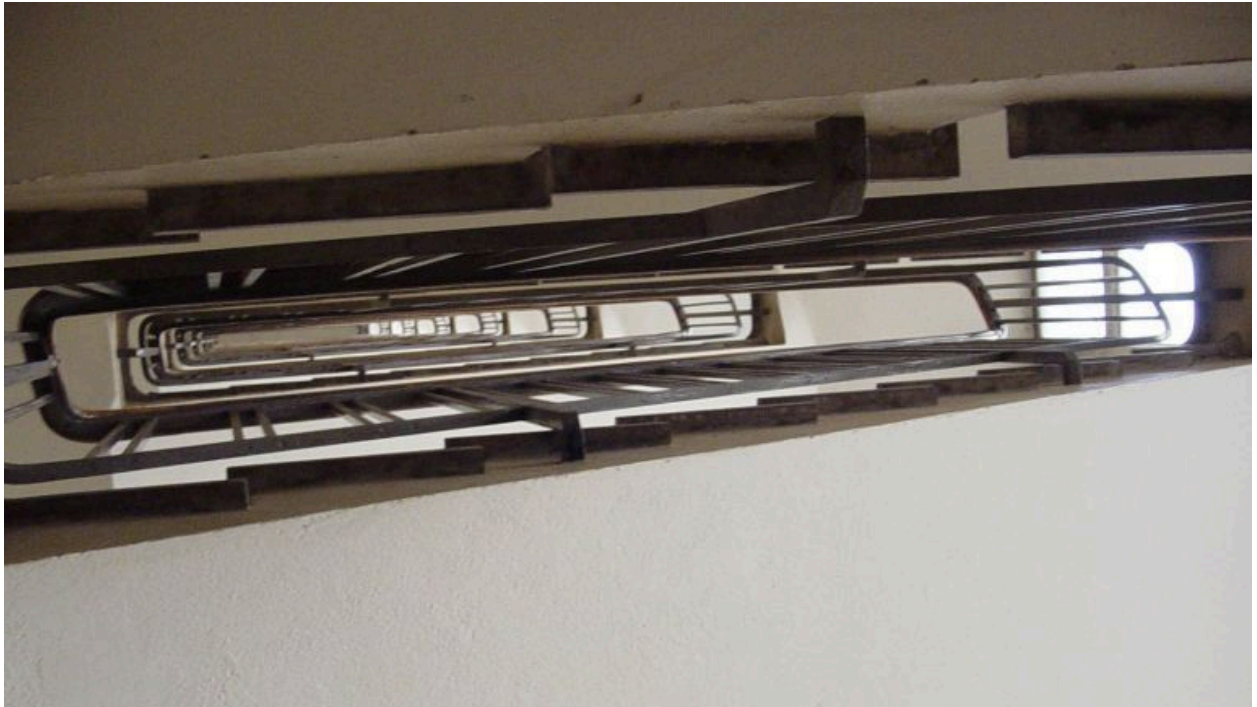
Cage d'escalier vu de dessous
