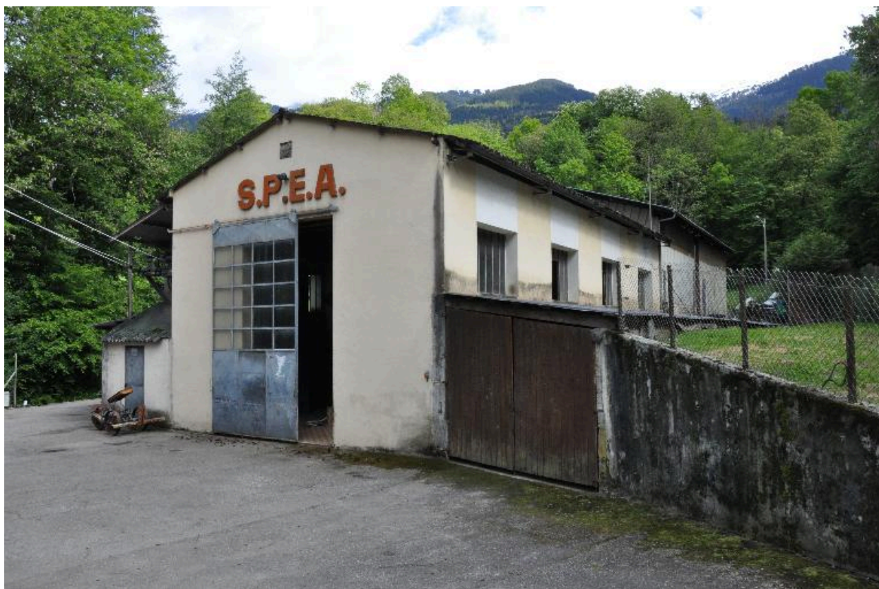
Vue de la centrale.
