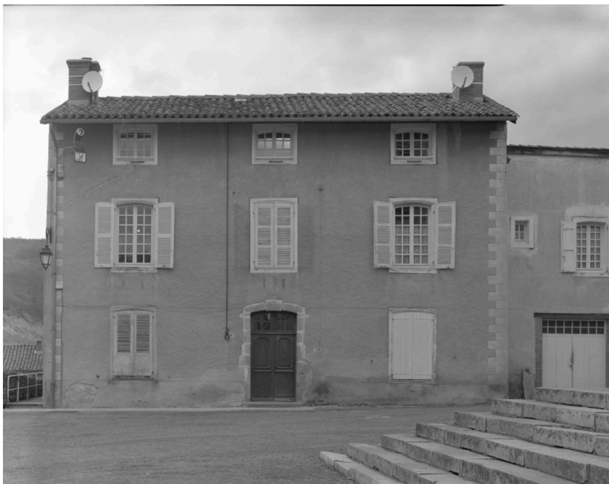
Vue d'ensemble de l'élévation antérieure.
