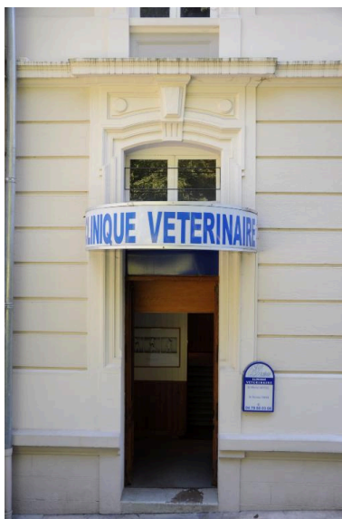
Porte d'entrée sur la façade postérieure (est) Phot. Denys Harreau IVR82_20137301175NUCA
