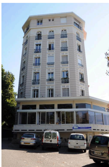
Façade latérale gauche (nord) Phot. Denys Harreau IVR82_20137301174NUCA
