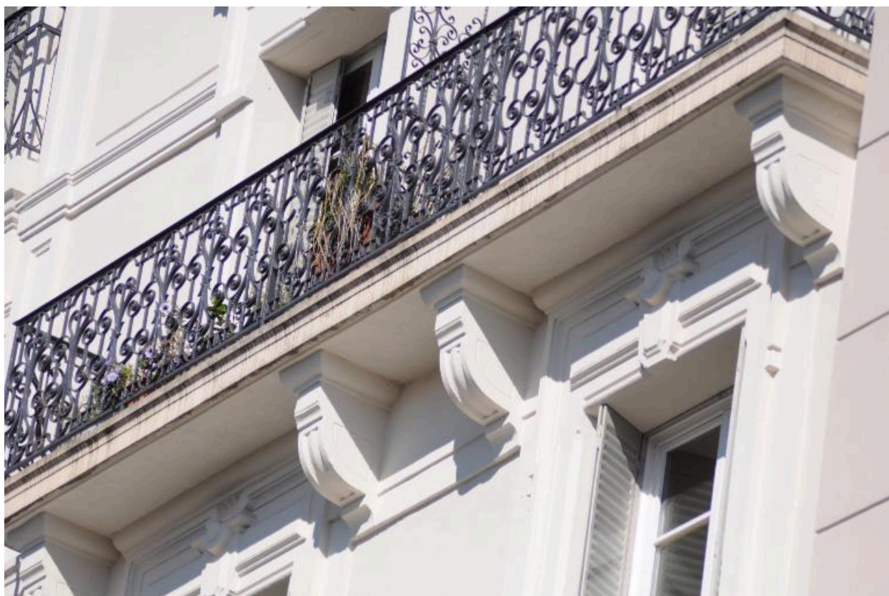
Dessus-de-fenêtres des baies du 3e étage et consoles des balcons du 4e étage
