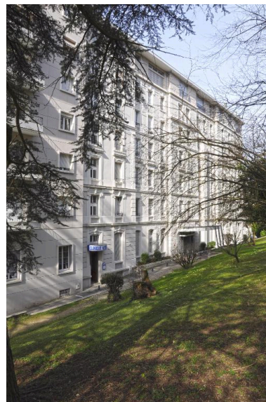
Façade postérieure (est) Phot. Denys Harreau IVR82_20147300134NUCAQ
