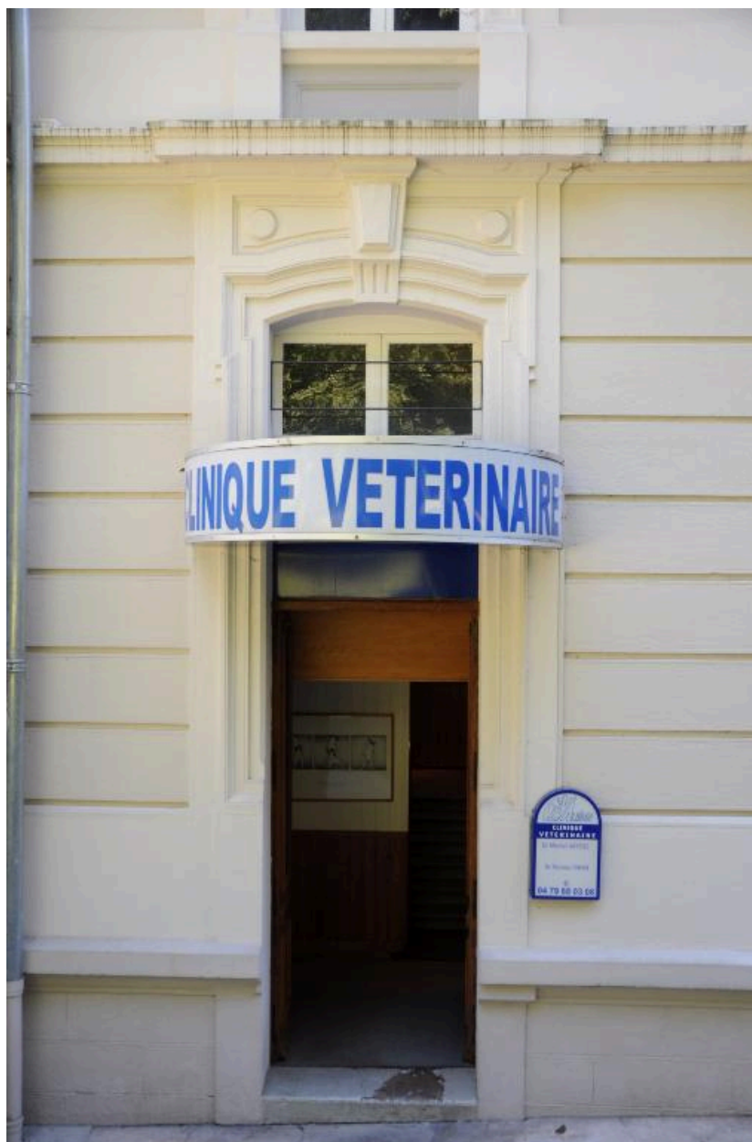
Porte d'entrée sur la façade postérieure (est)
