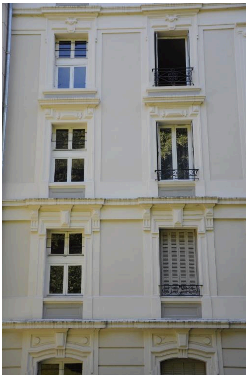
Baies des 1er, 2nd et 3e étages de la façade postérieure (est)
