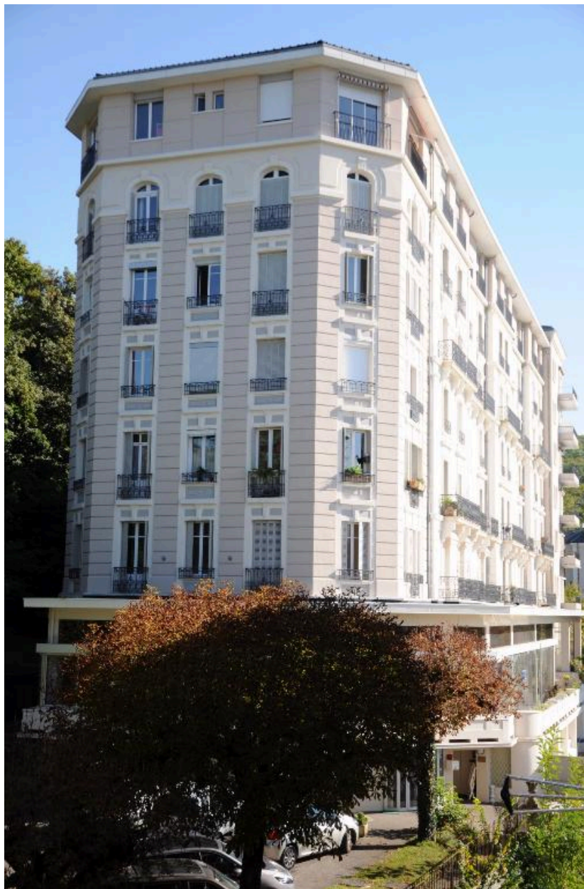
Vue d'ensemble depuis le nord : façade latérale gauche (nord) et façade principale (ouest)
