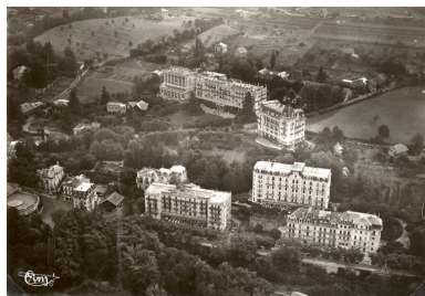
L'hôtel d'Albion, au centre, 1945-1952 Repro. Denys Harreau IVR82_20147300101NUCB
