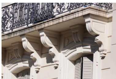
Dessus-de-fenêtres du rez-de- chaussée surélevé et consoles des balcons du 1er étage Phot. Denys Harreau IVR82_20137301181NUCA
