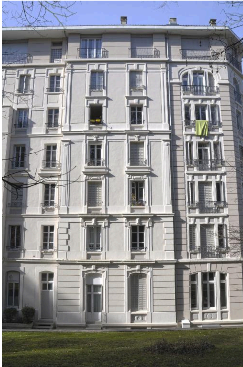
Détail de la façade postérieure (est)
