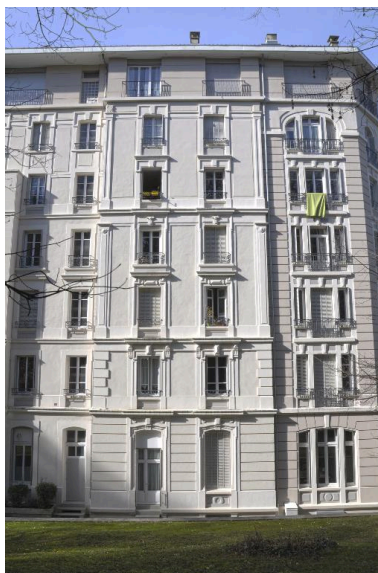
Détail de la façade postérieure (est) Phot. Denys Harreau IVR82_20147300217NUCAQ
