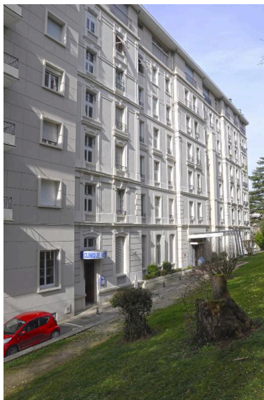
Façade postérieure (est) Phot. Denys Harreau IVR82_20147300135NUCAQ
