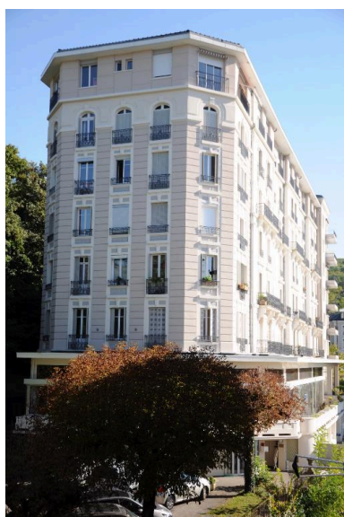
Vue d'ensemble depuis le nord : façade latérale gauche (nord) et façade principale (ouest) Phot. Denys Harreau IVR82_20137301188NUCA
