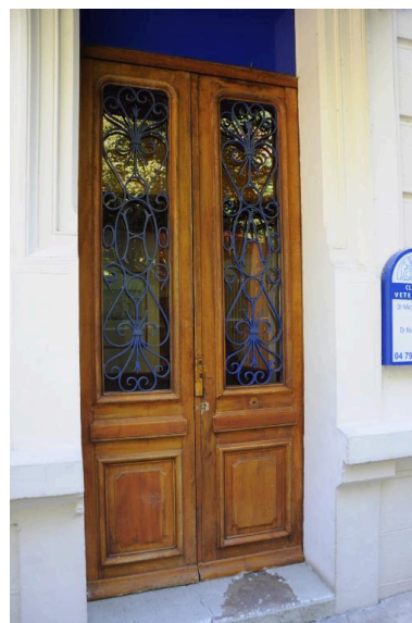
Monogramme dans la ferronnerie d'une porte d'entrée Phot. Denys Harreau IVR82_20137301179NUCA
