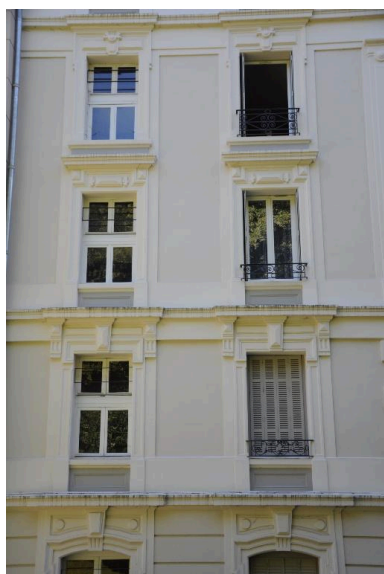
Baies des 1er, 2nd et 3e étages de la façade postérieure (est) Phot. Denys Harreau IVR82_20137301178NUCA
