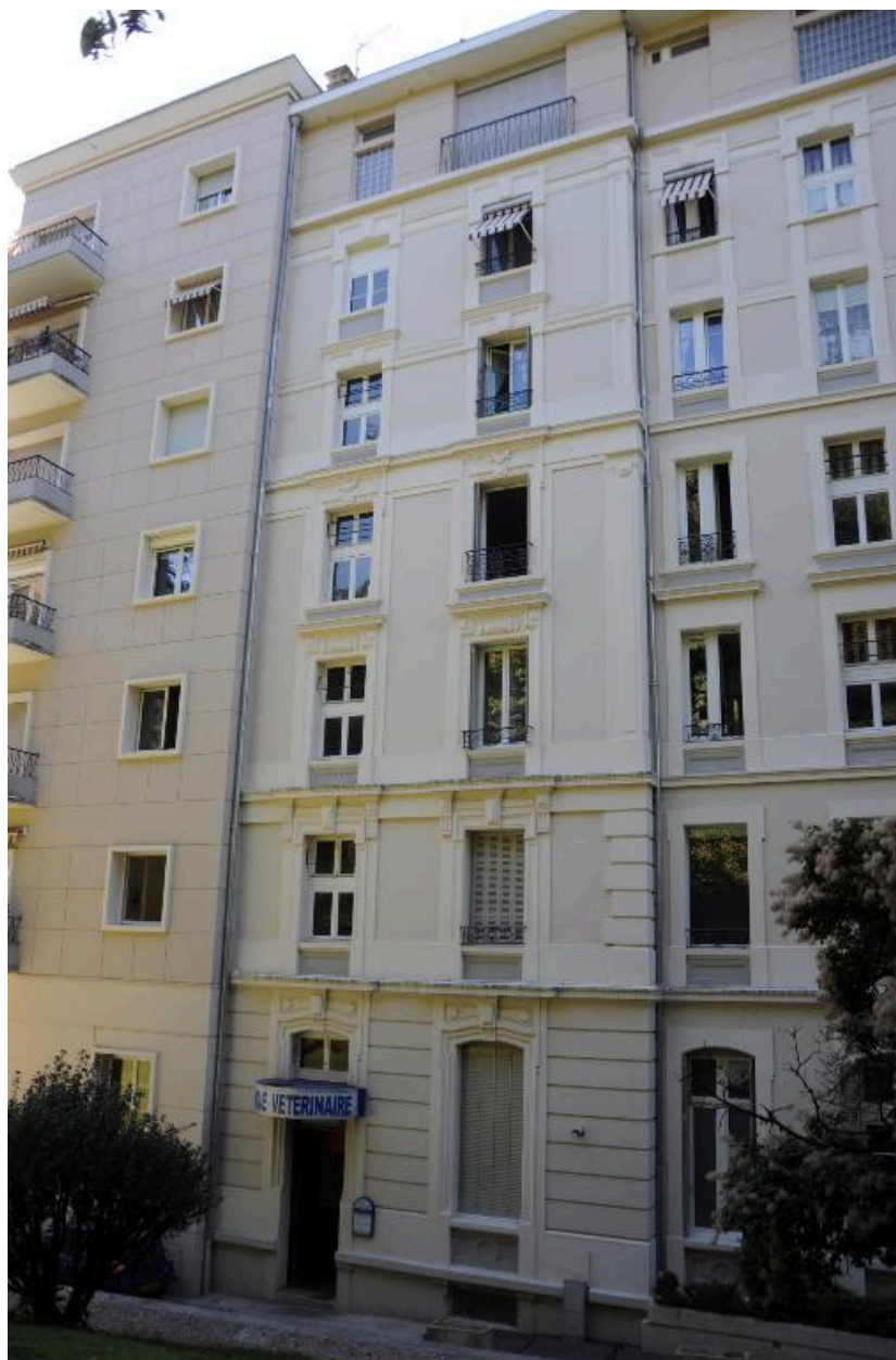
Détail de la façade postérieure (est)
