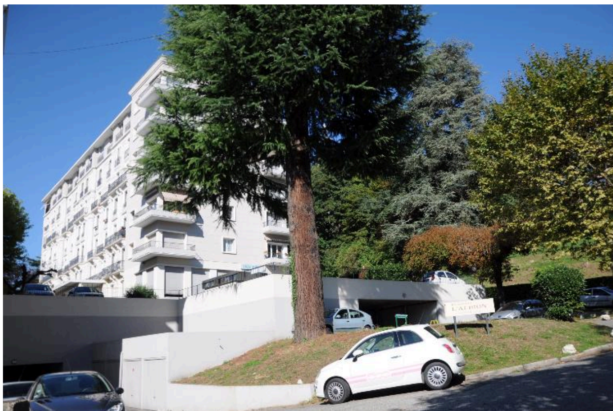
Vue d'ensemble depuis le sud : façade latérale droite (sud) et façade principale (ouest)
