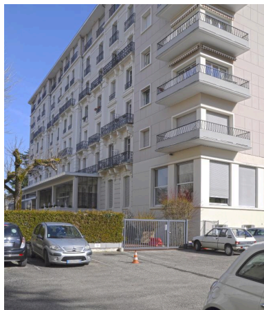
Façade principale (ouest) et latérale (nord) Phot. Denys Harreau IVR82_20147300132NUCAQ
