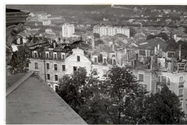
Façade est et toiture après incendie, 1963 Repro. Denys Harreau IVR82_20147300103NUCB
