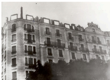
Façade ouest après incendie, 1963 Repro. Denys Harreau IVR82_20147300102NUCB
