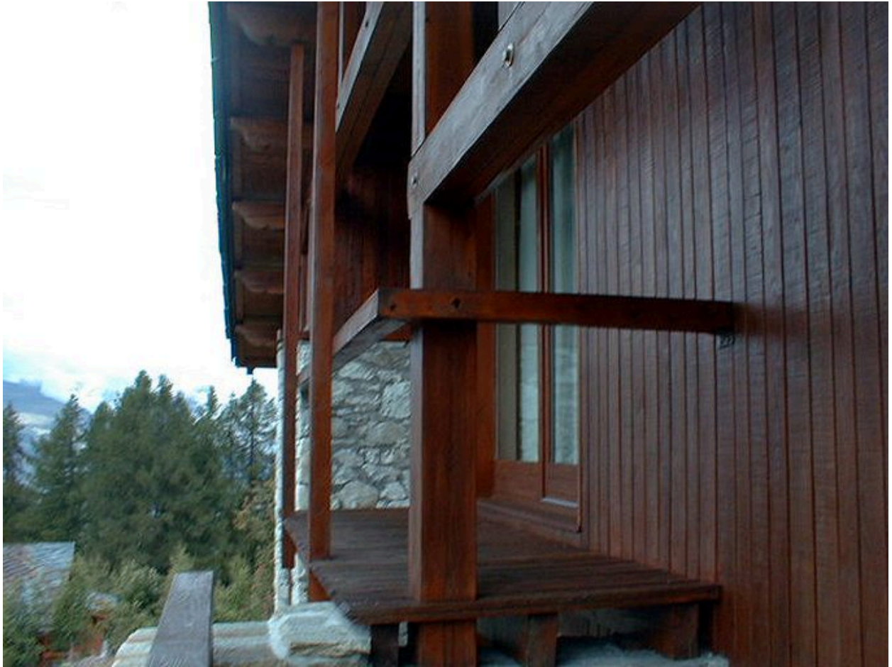
Détail d'une terrasse et du garde-corps
