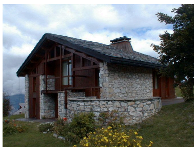
Façade sud-ouest Phot. C. Salomon IVR82_20057301492NUCA
