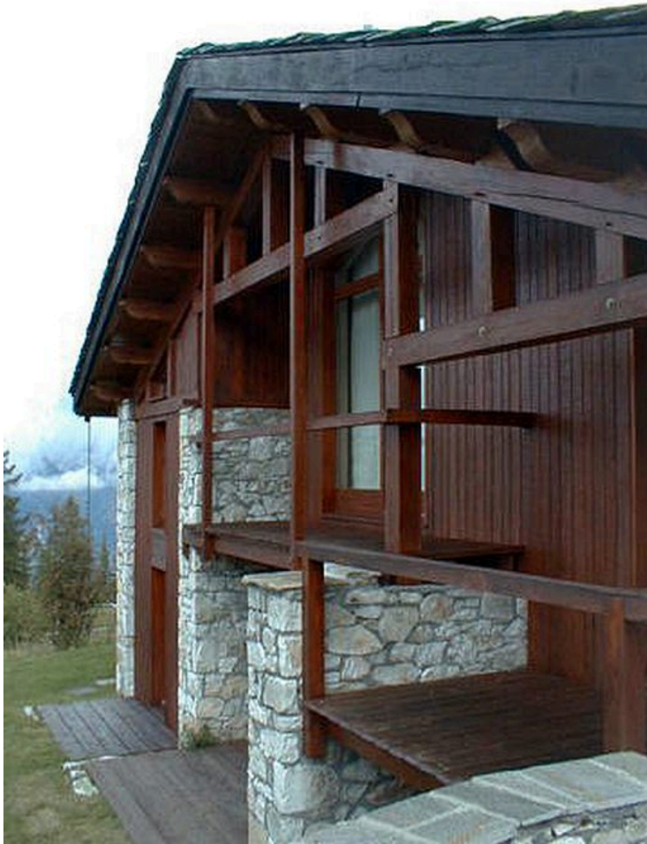
Façade sud-ouest, détail
