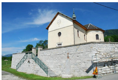
Vue d'ensemble du mur de soutènement ouest, avec son escalier, du cimetière. Phot. Thierry Monnet IVR82_20157302510NUCA
