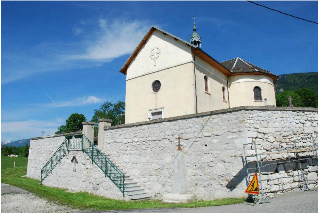
Vue d'ensemble du mur de soutènement ouest, avec son escalier, du cimetière.
