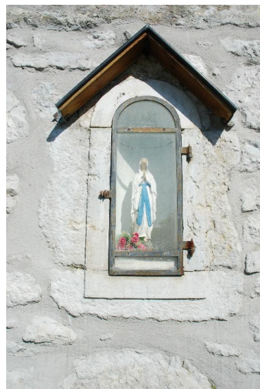
Vue d'ensemble de la niche placée dans le mur de soutènement ouest du cimetière. Phot. Thierry Monnet IVR82_20157302522NUCA
