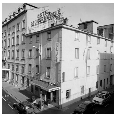
Vue générale Phot. Jean-Marie Refflé IVR82_20026900328X
