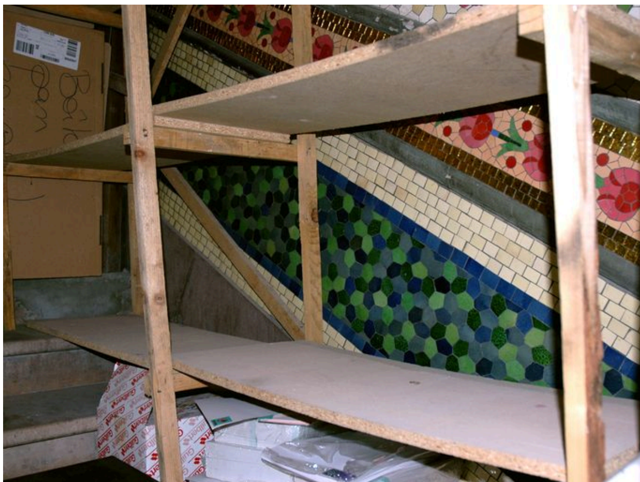
Départ de la volée d'escalier entre le 1er et le 2e étage
