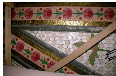
Volée d'escalier entre le 1er et le 2e étage : détail de l'extrémité supérieure de la volée Phot. Maryannick Chalabi IVR82_20076900277NUCA
