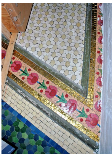
Détail de la 1ère volée d'escalier Phot. Maryannick Chalabi IVR82_20076900270NUCA
