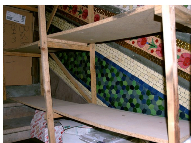
Départ de la volée d'escalier entre le 1er et le 2e étage Phot. Maryannick Chalabi IVR82_20076900272NUCA
