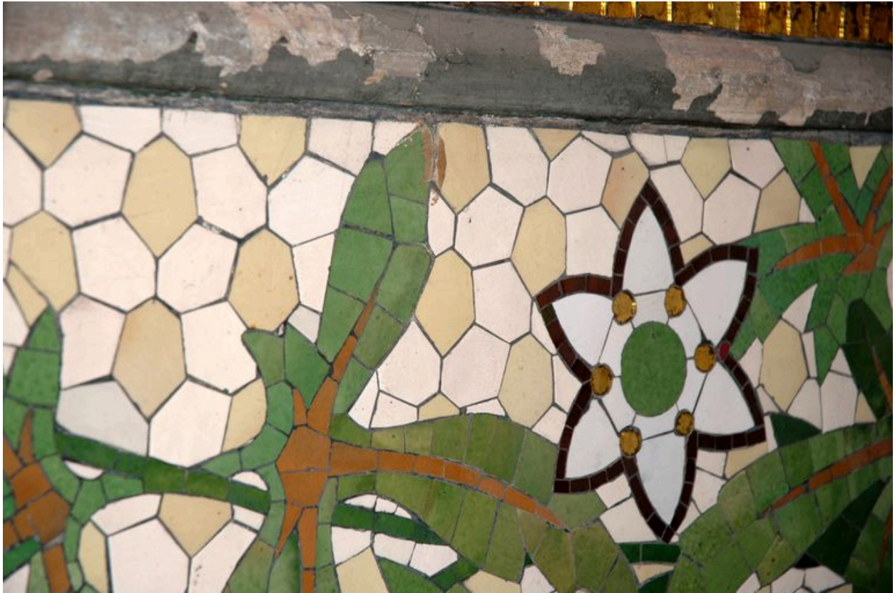
Volée d'escalier entre le 1er et le 2e étage : détail d'une clématite
