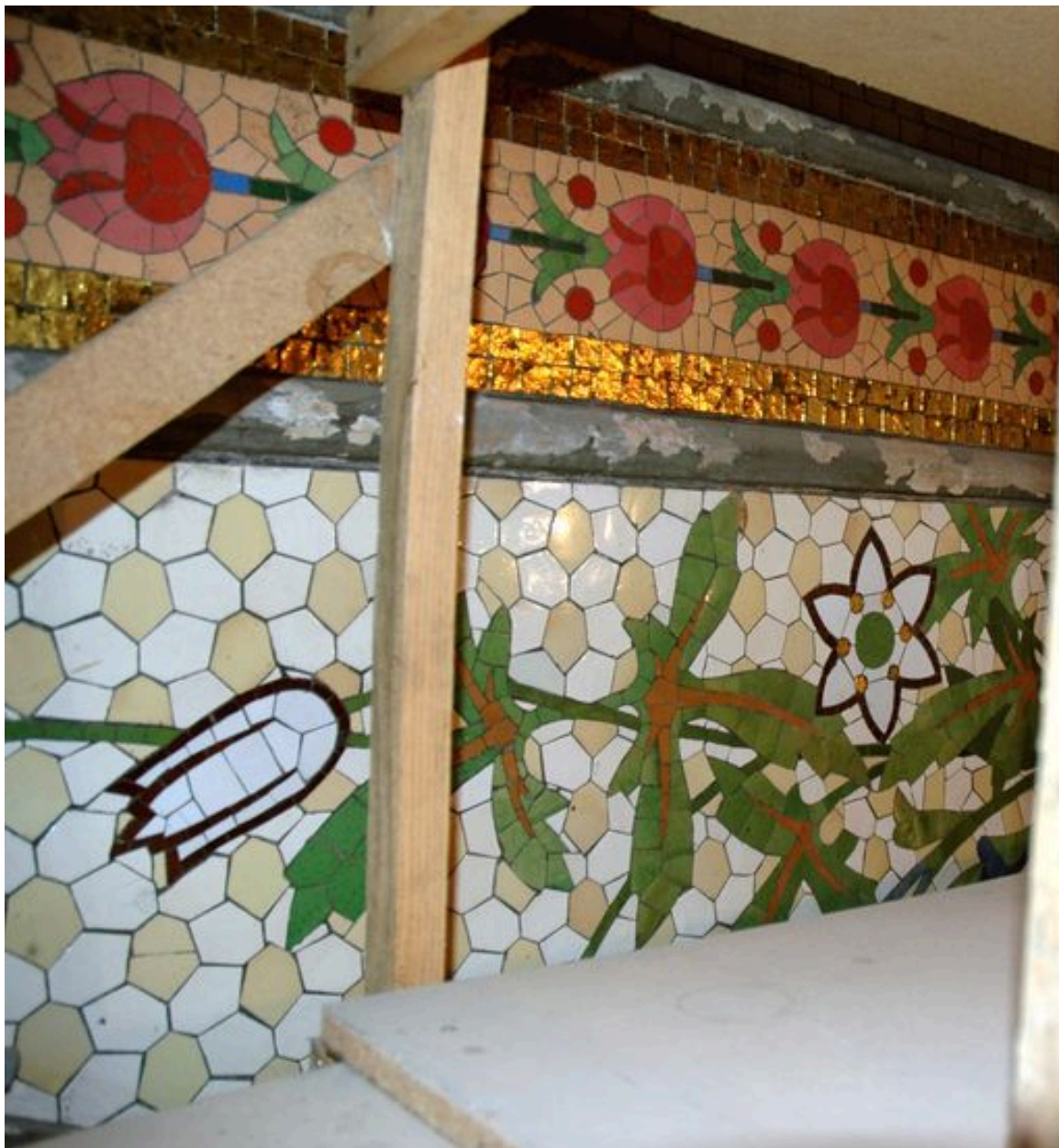
Volée d'escalier entre le 1er et le 2e étage : détail de la composition florale, partie supérieure
