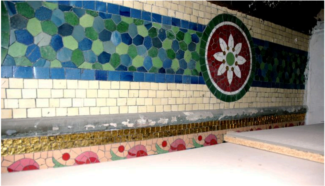
Partie supérieure de l'escalier : vue d'ensemble
