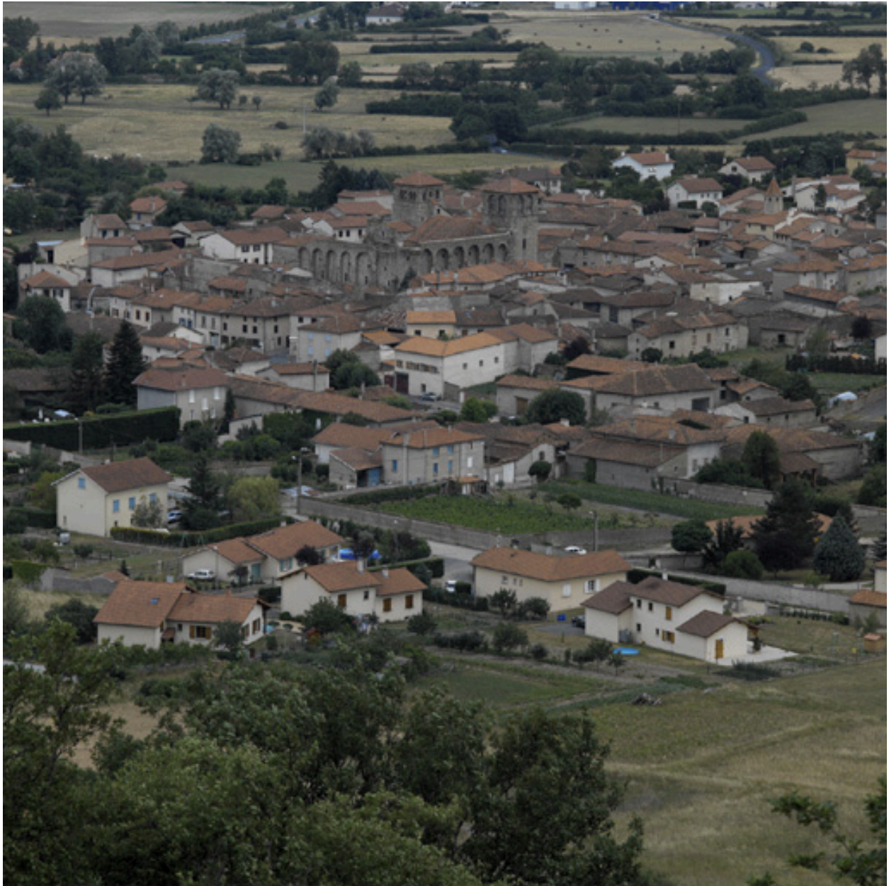
Vue du village depuis le pic de Purchon, au pied de la madone.
