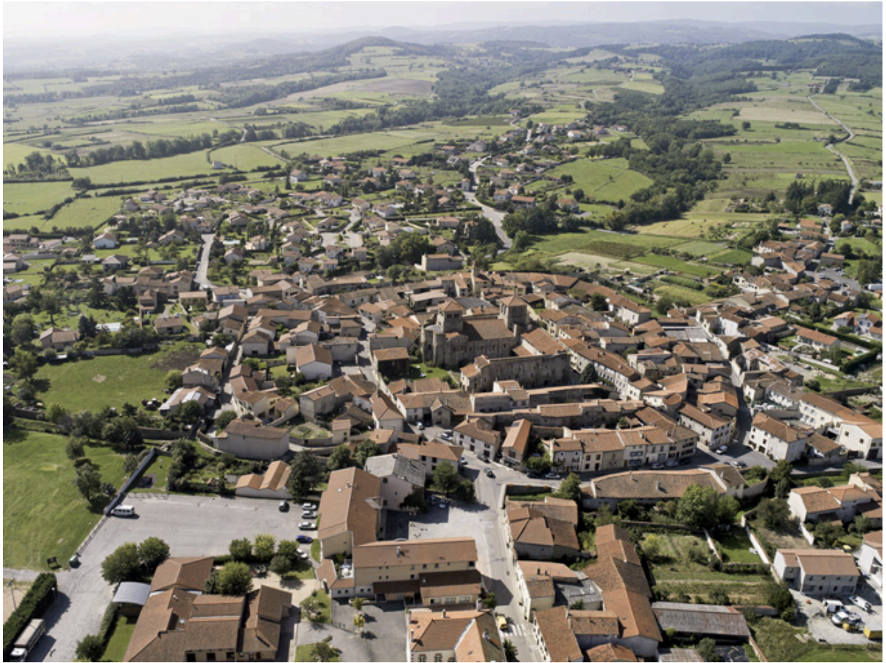
Vue générale aérienne, depuis le nord-ouest.
