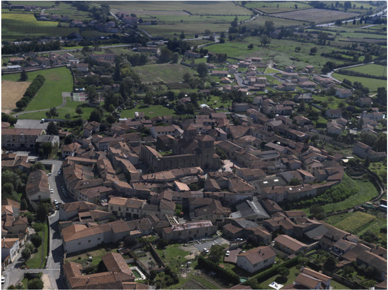
Vue générale aérienne, depuis le nord-ouest.
