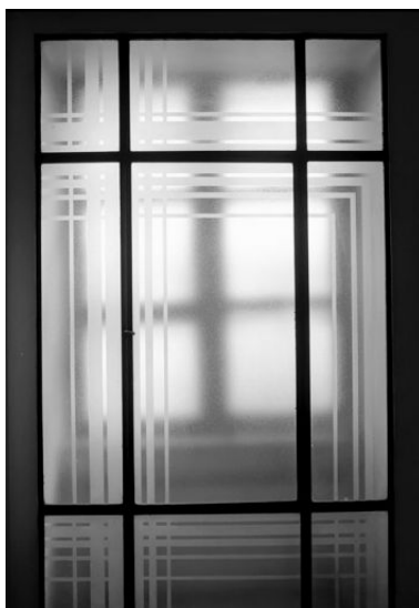
Fenêtre éclairant la cage du premier escalier Phot. Eric Dessert IVR82_20016902716X
