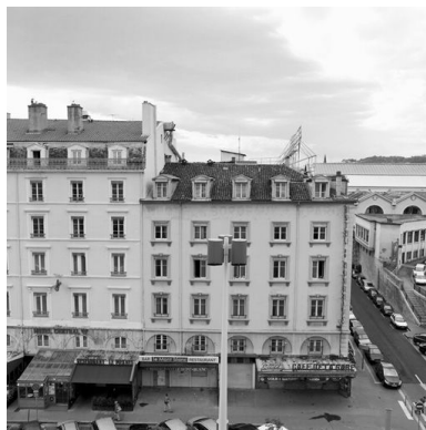
Elévation nord depuis les jardins suspendus (côté Rhône) du Centre d'Echanges Phot. Eric Dessert IVR82_20026903254X
