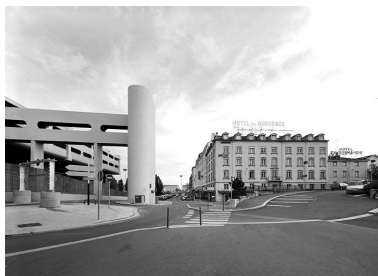
Elévations ouest et nord Phot. Eric Dessert IVR82_20016902713V
