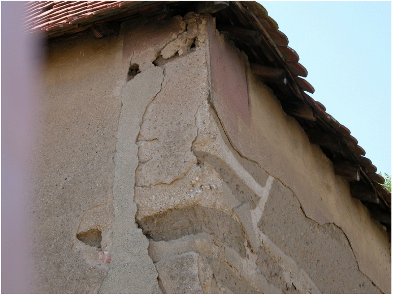
Détail de l'enduit peint.
