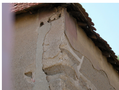
Détail de l'enduit peint. Phot. Thierry Monnet IVR82_20134200733NUCA
